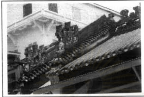
ภาพที่ 200 การปูกระเบื้องมุงเป็น รูปหลังคาขนาดเล็ก ครอบเหนือเมฆปิดหน้าจั่ว
