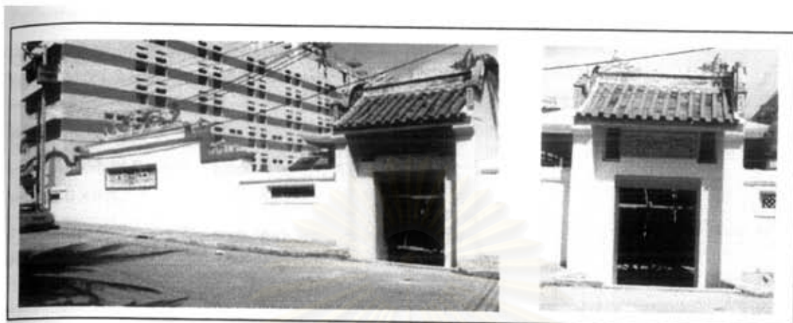
ภาพที่ 139 ฐานประตูทางเข้าแบบที่ 2 ที่วางอยู่สองข้างของแนวแกนอาคาร
