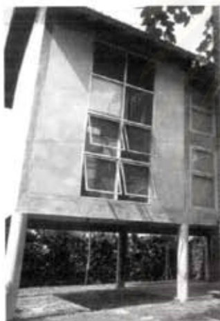
(จ) ลักษณะการยกใต้ถุนอาคาร
