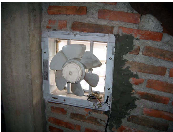
รูปที่ 3.20 แสดงการติดตั้งพัดลมระบายอากาศ
