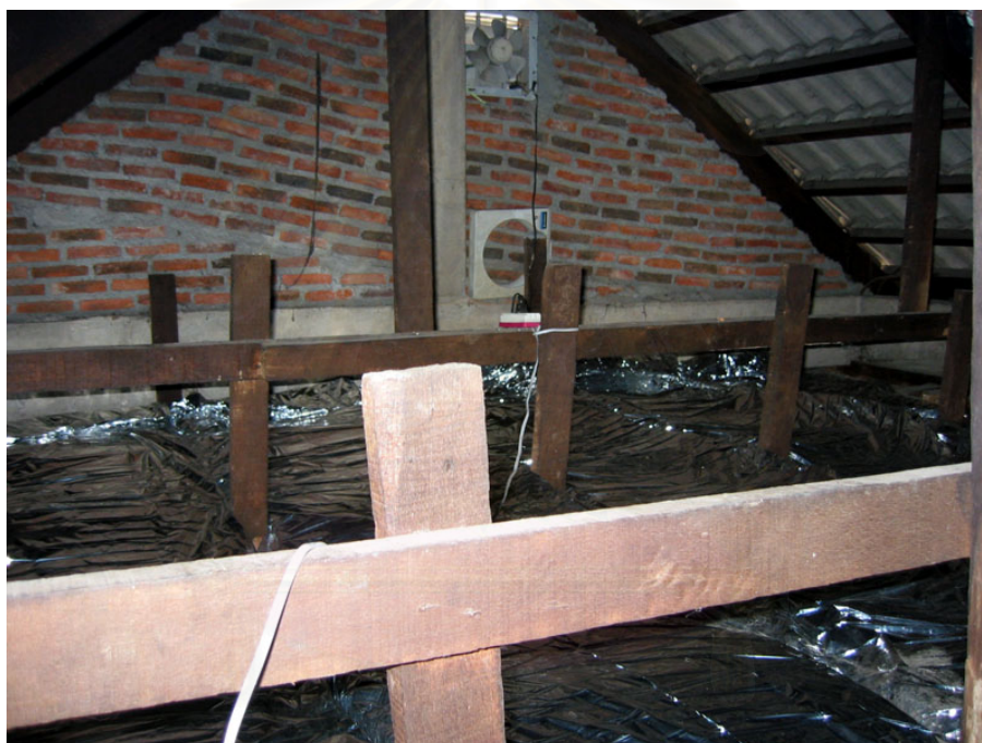
รูปที่ 3.6 แสดงสภาพภายในของหลังคาที่ทำการทดลองแบบมีฉนวน
