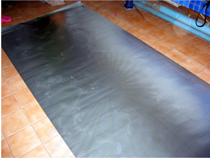
รูปที่ 3.12 แสดงแผ่นอลูมิเนียมพอยล์ก่อนทำการติดตั้ง
