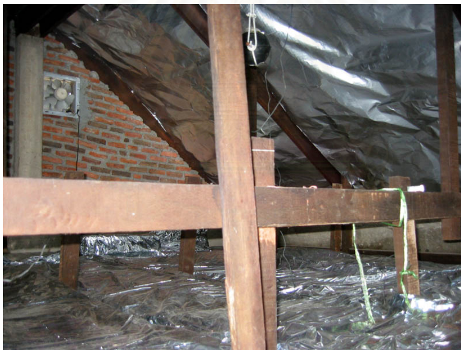
รูปที่ 3.13 แสดงสภาพภายในของหลังคาที่ทำการทดลองแบบใช้ฉนวนทั้ง 2 ชนิด
