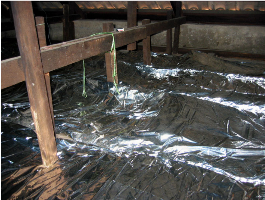
รูปที่ 3.7 แสดงสภาพภายในของหลังคาที่ทำการทดลองแบบมีฉนวน
