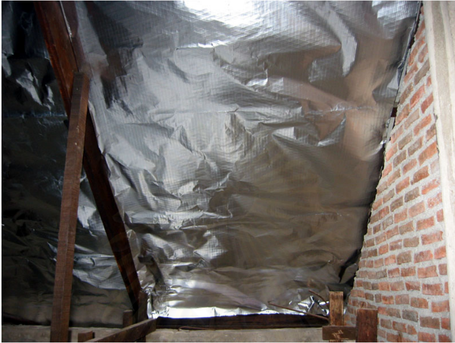
รูปที่ 3.10 แสดงสภาพภายในของหลังคาที่ทำการทดลองกับแผ่นอลูมิเนียมฟอยล์
