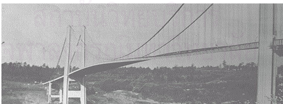
รูปที่ 2.4 แสดงการเสียรูปจากแรงบิดคังของสะพานทาโคมา (Irvine, 1999)
