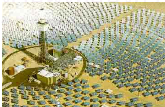
รูปที่ 1.1: การรวบรวมความร้อนจากแสงอาทิตย์โดยใช้เฮลิโอสแตท
