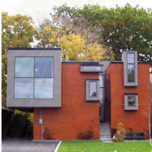
ภาพที่ 5.34 รูปถ่ายอาคารที่นำมาทดสอบ
