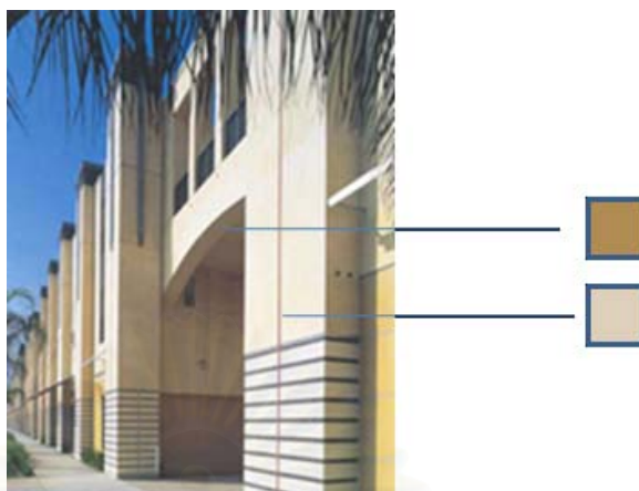
ภาพที่6.4 ความคลาดเคลื่อนของสีจากการเกิดเงา
