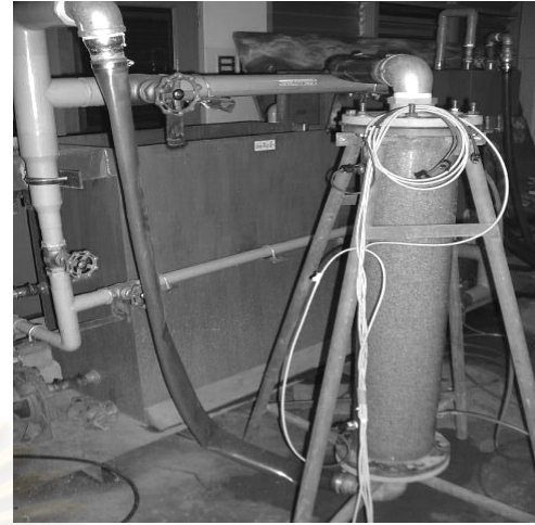
รูปที่ ง-28 การต่อท่ออ่อนเข้าระบบหมุนเวียนน้ำ
