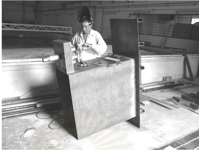
รูปที่ ง-3 การประกอบถังเก็บน้ำ
