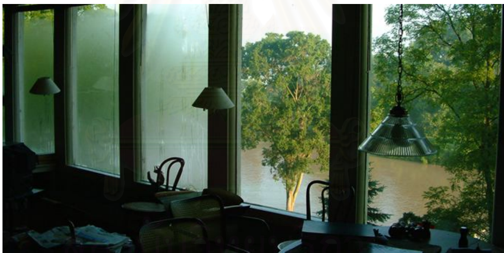
รูปที่ 2.1 แสดงลักษณะการเกิดการควบแน่นที่ผิวกระจก
