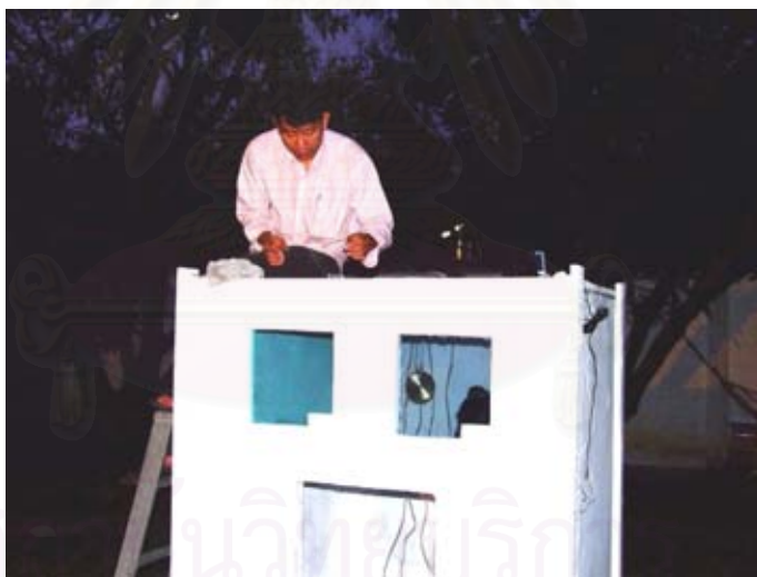
รูปที่ 3.20 แสดงการติดตั้งหัววัดอุณหภูมิที่บริเวณผิวกระจกทดลอง
