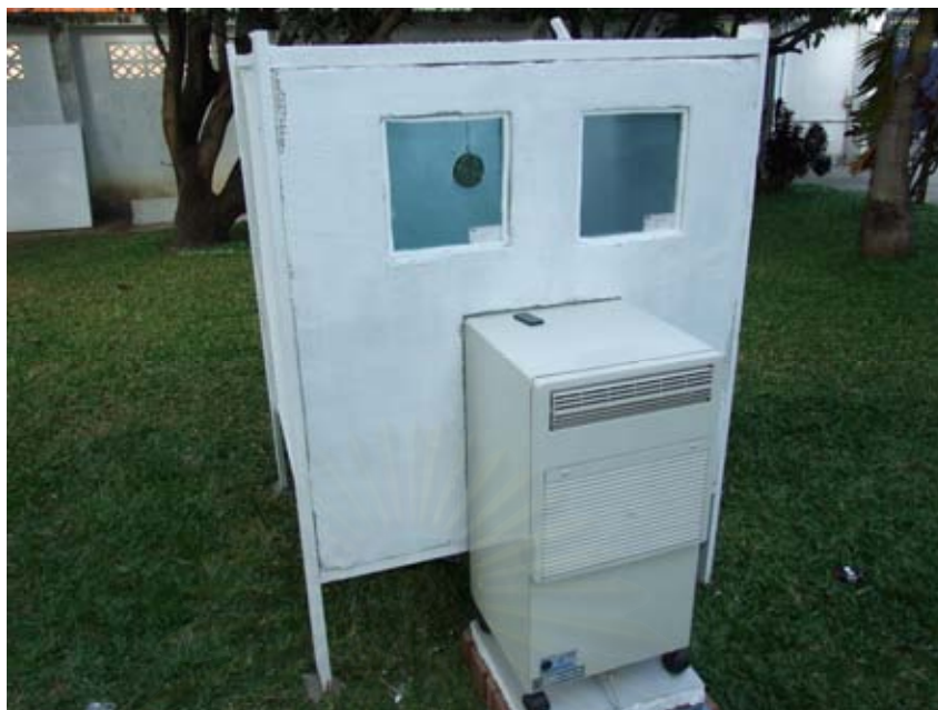
รูปที่ 3.26 แสดงการติดตั้งเครื่องปรับอากาศขนาด 6,000 Btu/hr.
