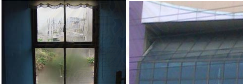
รูปที่ 1.2 การเกิดการควบแน่นที่ผิวกระจกและคราบสกปรกที่ผิวกระจก
