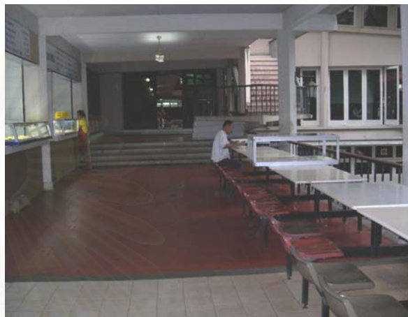
รูปที่ 4.50 ทางเชื่อมระหว่างอาคารจุลจักรพงษ์
