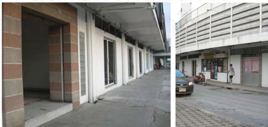
รูปที่ 4.89 บริเวณทางเข้าอาคาร รอบอาคาร
