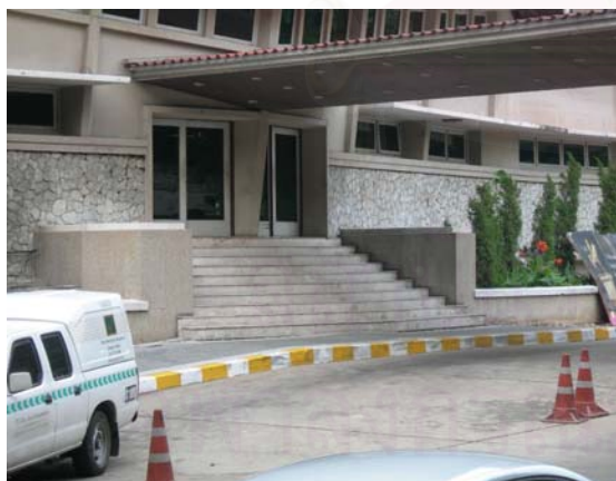
รูปที่ 4.51 ประตูทางเข้าด้านหน้าอาคาร
