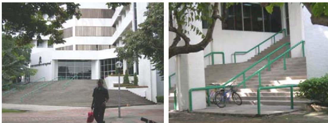
รูปที่ 4.33 บันไดด้านทางเข้าหลักด้านหน้าและด้านข้าง
