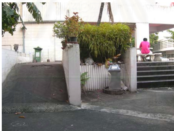
รูปที่ 4.99 บันไดภายนอกอาคารและทางลาด
