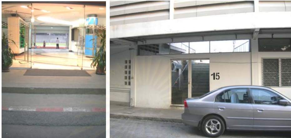
รูปที่ 4.90 ประตูกระจกทางเข้าหลักและประตูโดยรอบอาคาร
