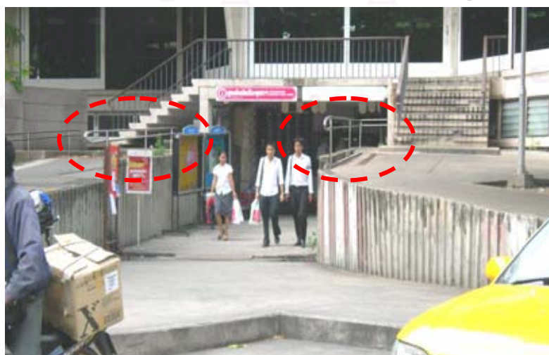
รูปที่ 4.56 แนวทางตามข้อคิดเห็น ในการปรับปรุงราวกันตกบริเวณทางขึ้นชั้นบนอาคารศาลาพระเกี้ยว
