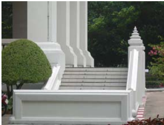
รูปที่ 4.73 บันไดภายนอกด้านหน้าอาคาร
