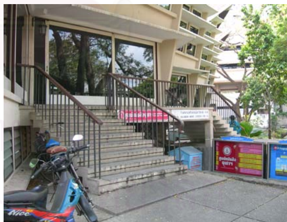
รูปที่ 4.52 ประตูบริเวณด้านข้างอาคาร
