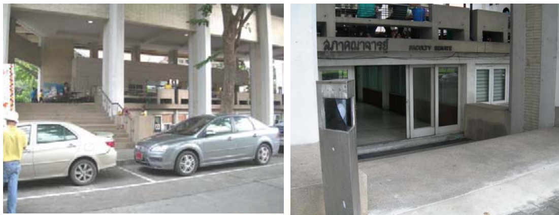
รูปที่ 4.63 บริเวณทางเข้าอาคารโดยมีฟุตบอลก่อนไปสู่โรงอาหารชั้น1 และสภาคณาจารย์ชั้นใต้ดิน นอกจากนี้ทางเข้าอาคารด้านหน้าโดยฟุตบอลจะเป็นทางไปสู่สภาคณาจารย์ ที่มีการลดระดับลงไปใ ชั้นใต้ดินด้วย ลักษณะพื้นที่บริเวณรอบอาคารเป็นคอนกรีตตัวหนอนแยกระหว่างถนนและฟุตบอล
