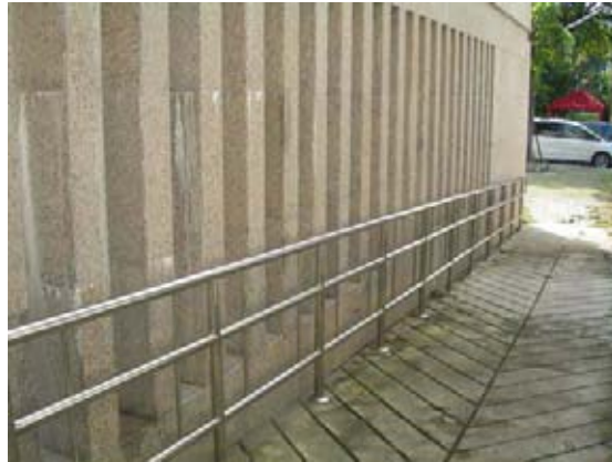
รูปที่ 4.22 ทางลาดเข้าอาคาร
