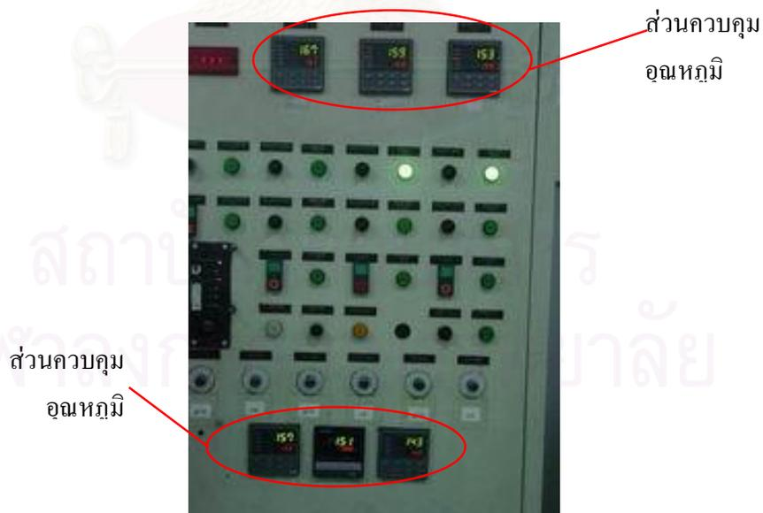
รูปที่ 4. ชุดควบคุมอุณหภูมิ
