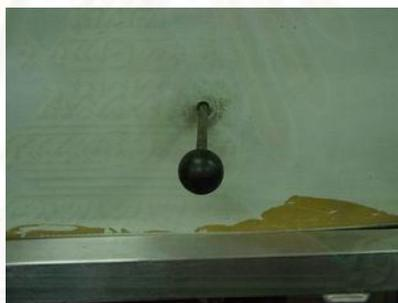
รูปที่ 19. วาล์วกระจายอุณหภูมิ
