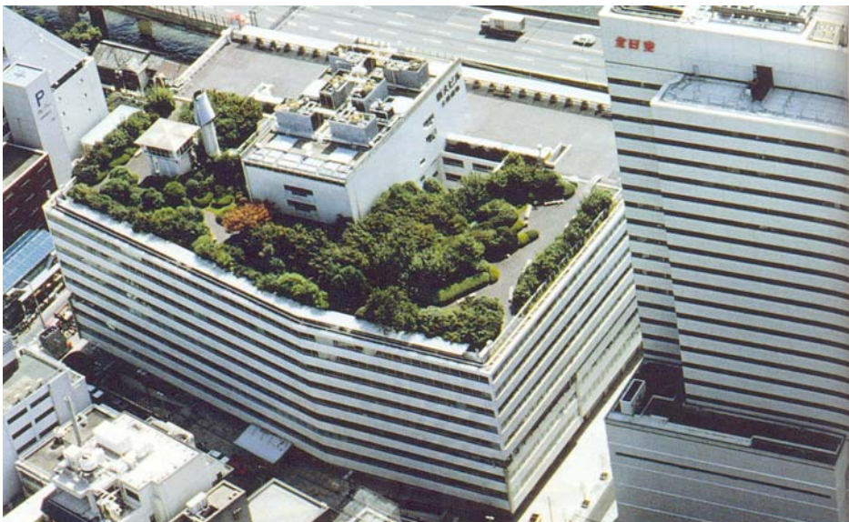
ภาพที่ 2.17 สวนต้นไม้บนดาดฟ้าอาคารชินได นครโอซาก้า (ที่มา: Kato, 109-110)
