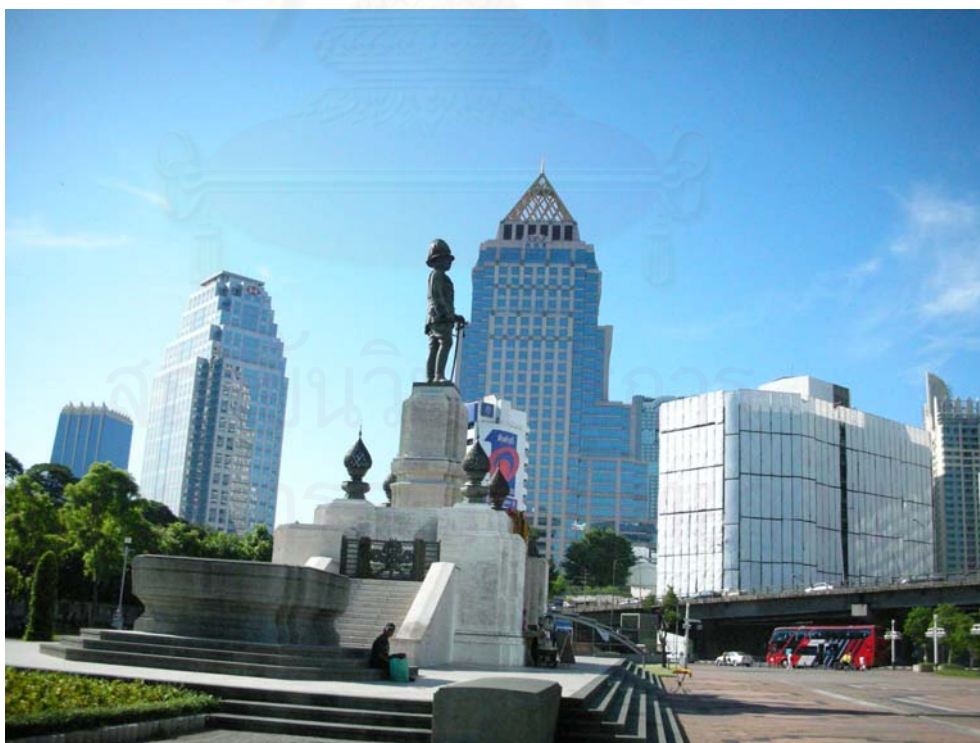
ภาพที่ 2.1 แสดงกลุ่มอาคารสูงบริเวณสวนลุมพินี (ที่มา : จากการสำรวจโดยผู้วิจัย)
