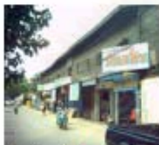
สำนักงานเล็กและพักอาศัย
