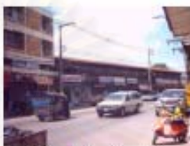
สำนักงานเล็กและพักอาศัย
