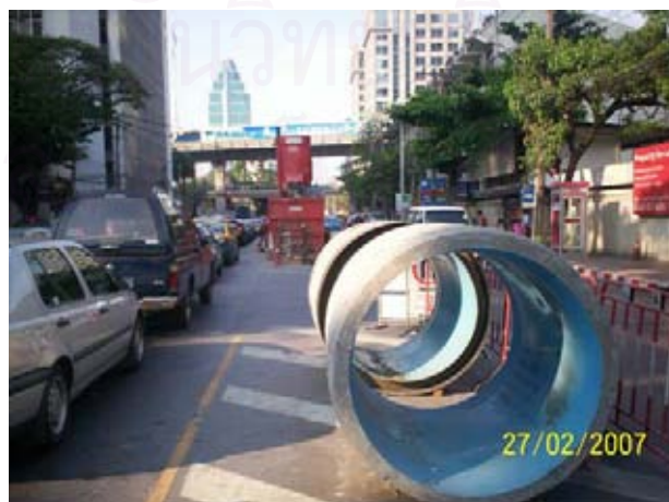
รูปที่ 2.21 แนวท่อแบบ Single Pass ในประเทศไทย
