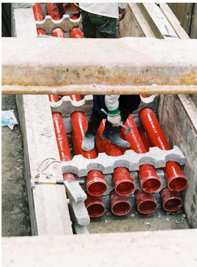
รูปที่ 2.33 การวางแนวท่อร้อยสายไฟฟ้าใต้ดินแบบขุดเปิดหน้าดินก่อนเทคอนกรีต
