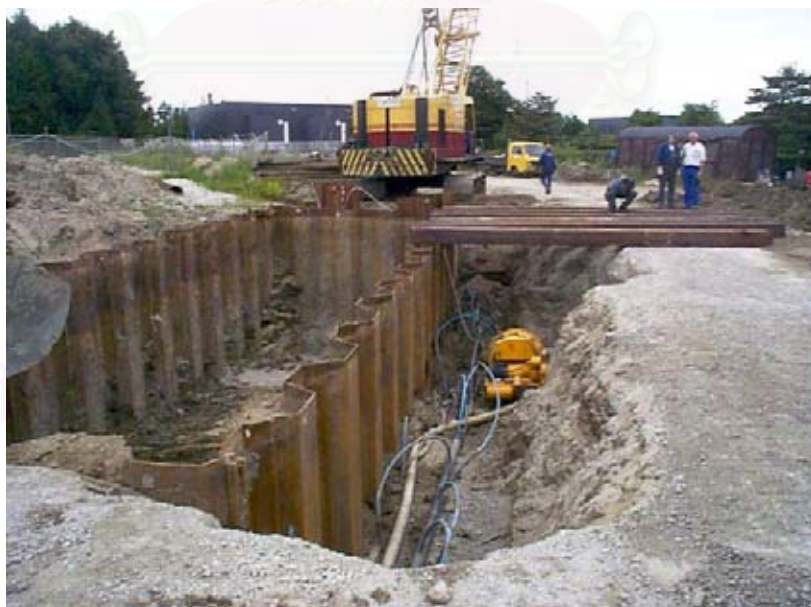
รูปที่ 2.36 การขุดเปิดหน้าดินโดยใช้เข็มพืดป้องกันดินพัง
