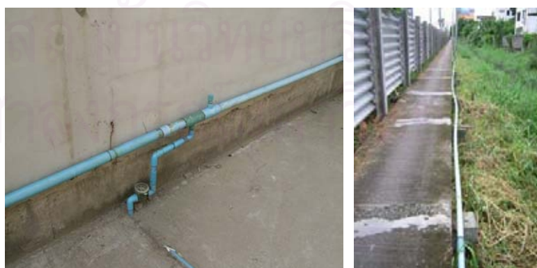
ภาพที่ 4.10 การวางท่อประปา (จากการสำรวจ, 2549)
