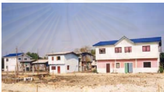
ภาพที่ 5.2 บ้าน 3 หลังที่สร้างก่อนในชุมชนคลองลำนุ่น (พช.2548)
