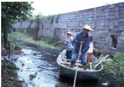
ภาพที่ 5.37 การขุดลอกคูคลองในคลองลำนูน
