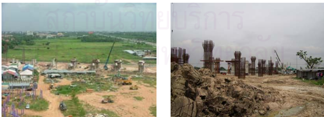
ภาพที่ 5.40 โครงการก่อสร้างทางด่วนรัชดาภิเษก – รามอินทราบริเวณด้านหลังชุมชนคลองลำนูน ( จากการสำรวจ,2549)
