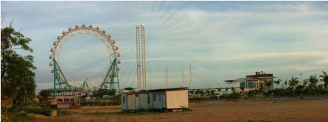
ภาพที่ 6.3 โครงการก่อสร้างสวนสนุก (จากการสำรวจ, 2549)
