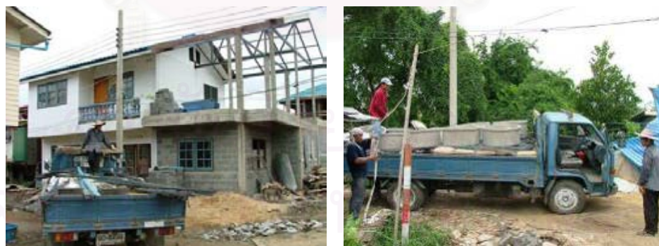
ภาพที่ 5.26 วัสดุอุปกรณ์ก่อสร้างที่ใช้ในการสร้างบ้าน (จากการสำรวจ, 2549)
