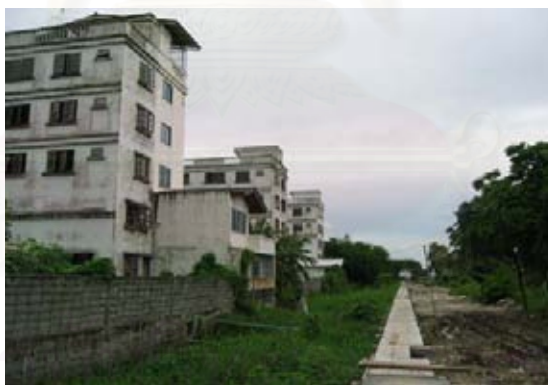
ภาพที่ 4.7 สภาพคลองลำนุ่นก่อนขุดลอกคลอง
