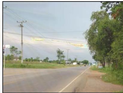
ทางหลวงจังหวัดสาย 3162 (ช่วงเทศบาลตำบลปากน้ำประแสร์)
