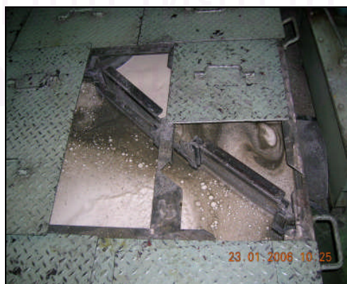
รูปที่ 3.2 ระบบกำจัดน้ำมันสกปรกออกจากถังพัก
