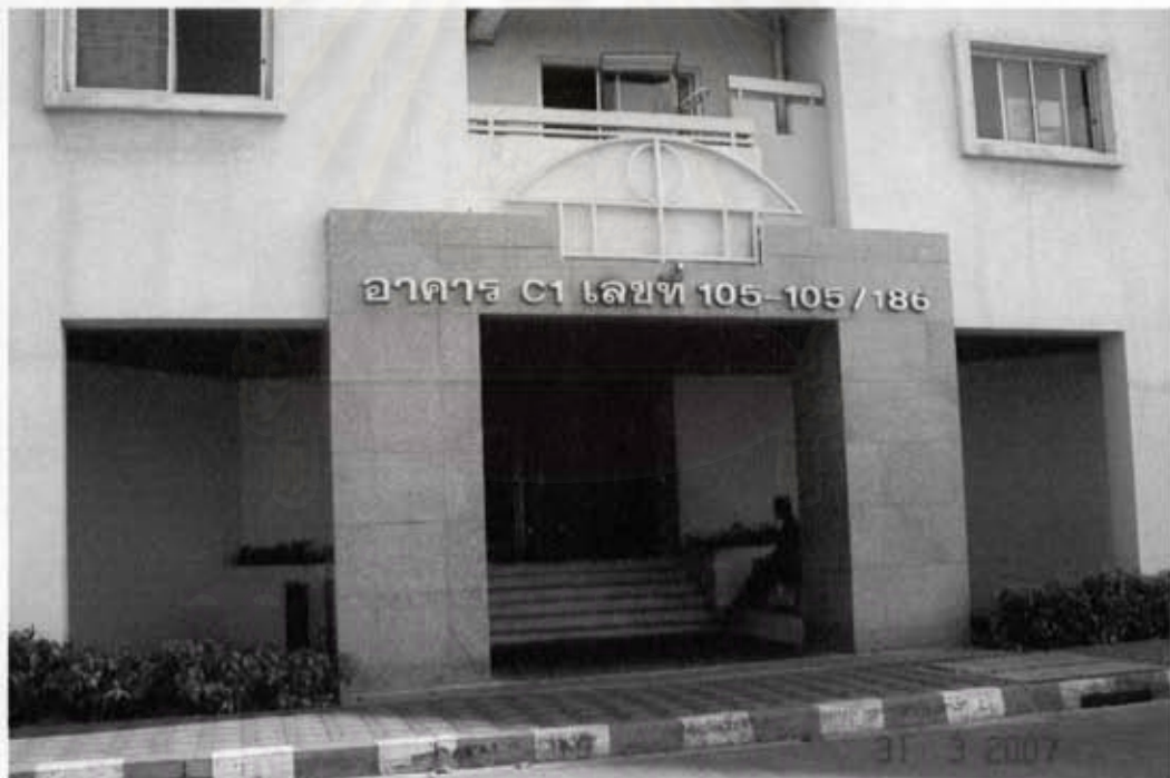
ภาพที่ 4.6 ด้านหน้าทางเข้าอาคาร C1
