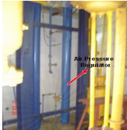
รูปที่ 3.5 Air Pressure Regulator
