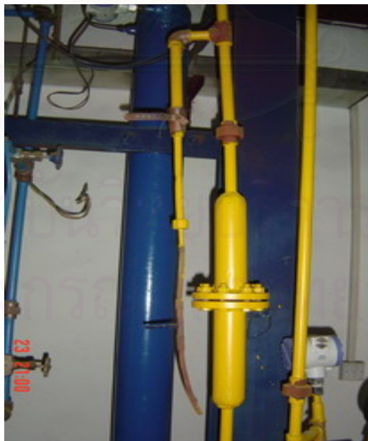
รูปที่ 3.15 จุดเก็บตัวอย่าง (Sampling Point)
