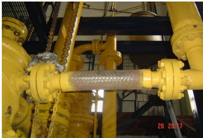
รูปที่ 3.3 อุปกรณ์ป้อนถ่านหินเข้าเครื่องผลิตก๊าซ (Screw Conveyor)
