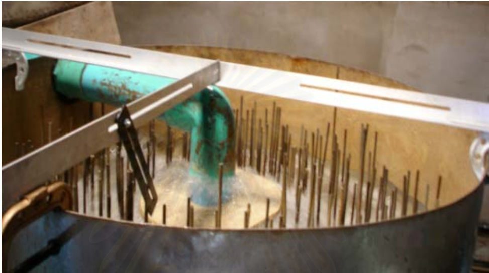
รูปที่ 4.8 การติดตั้งชุดจับยึดขอบเครื่องทำน้ำแข็ง
