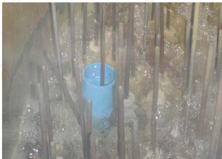
รูปที่ 4.11 การติดตั้งอุปกรณ์สำหรับกั้นน้ำ
