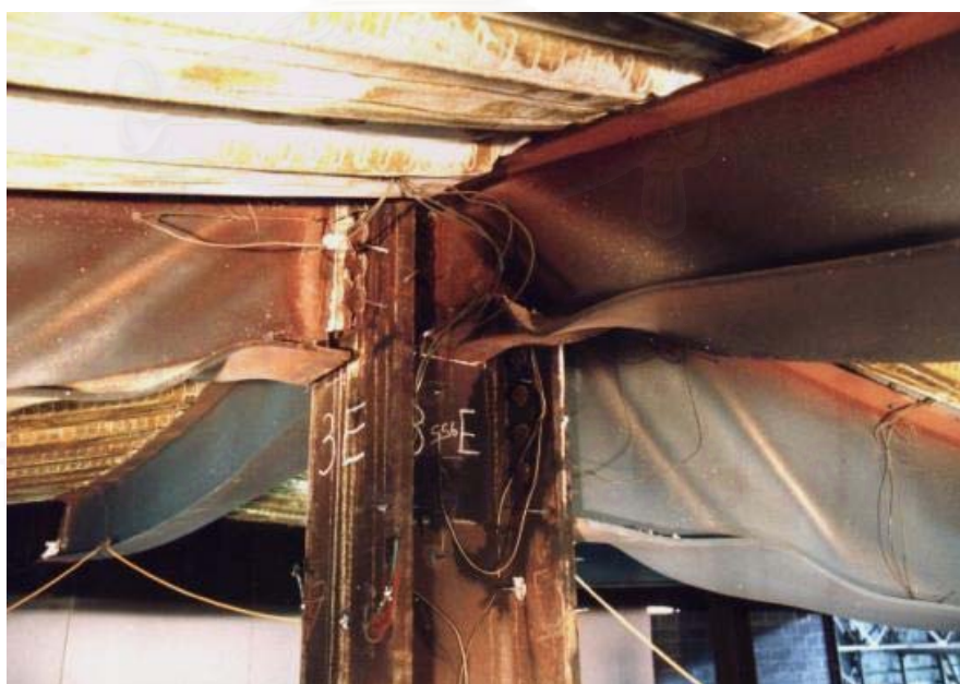
รูปที่ 2-4 การโก่งเดาะของเหล็กรูปพรรณภายหลังการเกิดไฟไหม้
