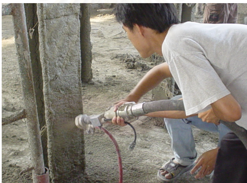
รูปที่ 3-5 แสดงการพ่นวัสดุเคลือบผิวป้องกันไฟบนเหล็กรูปพรรณ
