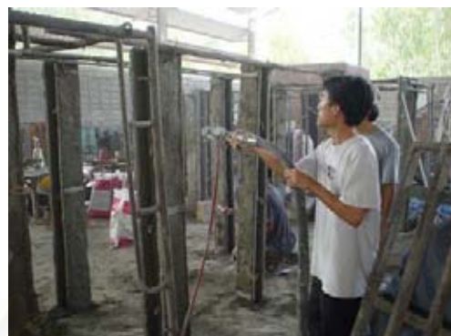
รูปที่ ช-4 แสดงการผสมวัสดุผสมเพอร์ไลต์แห้งกับน้ำในกะบะผสมเพื่อคลุกให้เข้ากันก่อนนำลงเครื่องพ่น และนำส่วนผสมใส่ลงในเครื่องพ่น
