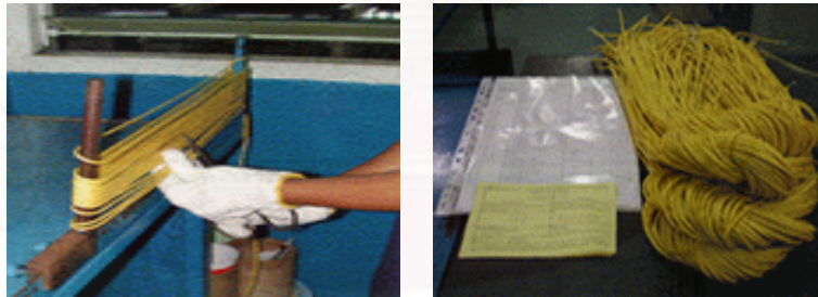
รูปที่ 4.71 การตัดสายไฟ
