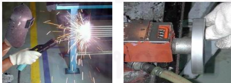
รูปที่ 4.22 การเชื่อมท้ายเหล็กและตัดส่วนเกิน
