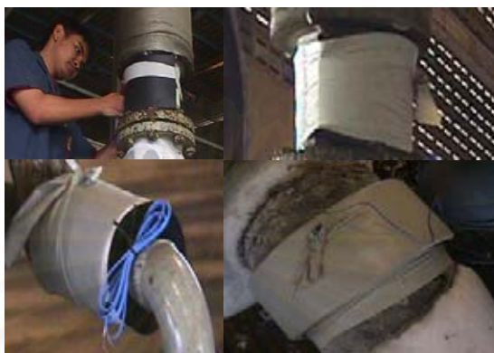
รูปที่ 6.10 การหุ้มฉนวนกันความร้อน
