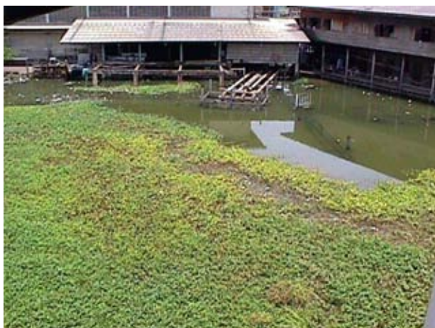
รูปที่ ๓3 บ่อน้ำที่นำน้ำมาใช้ในการหล่อเย็นเครื่องควบคุมแน่นในช่วงฤดูหนาวและฤดูร้อน
