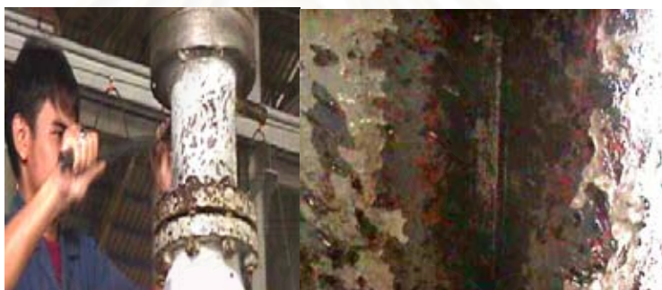
รูปที่ 6.8 การขูดสีและสิ่งสกปรกที่ผิวท่อออกให้เห็นเนื้อท่อ
