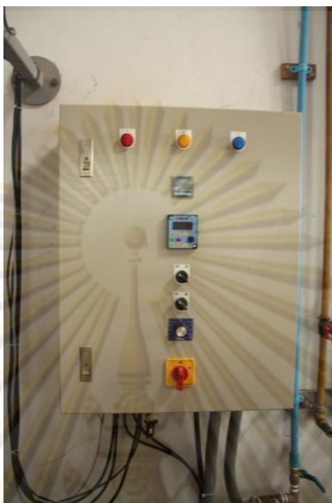
รูปที่ ง-5 ไมโครที่ใช้ในการควบคุมเครื่องแลกเปลี่ยนความร้อน
