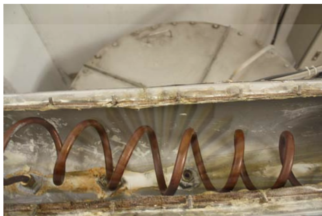
รูปที่ ง-3 ลักษณะการวางท่อขดในเครื่องแลกเปลี่ยนความร้อน
