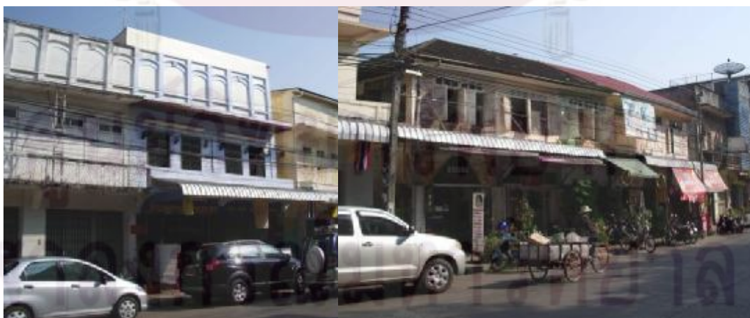
รูปภาพ 6- 6 ลักษณะอาคารเก่าและอาคารที่เกิดขึ้นในบริเวณพื้นที่ศึกษา แสดงถึงความไม่กลมกลืนของรูปแบบอาคาร
