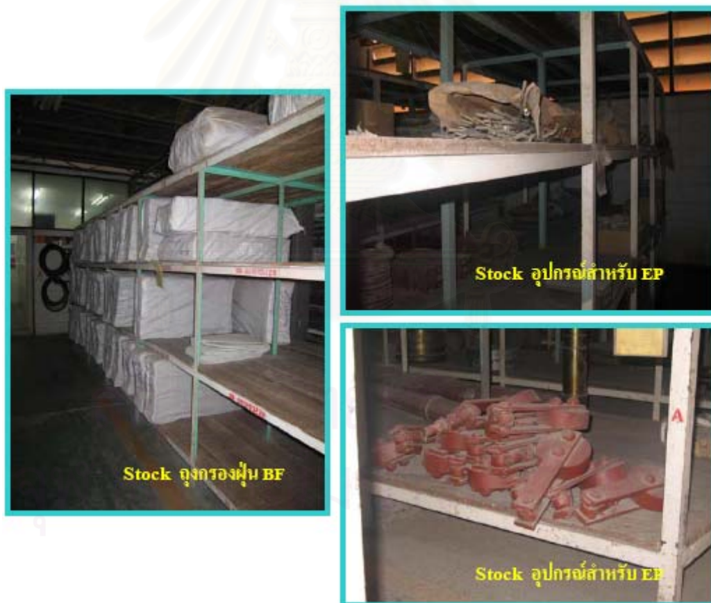
รูปที่ ง.2 : Stock อุปกรณ์สำหรับระบบดักฝุ่นชนิดถุงกรอง (BF) และระบบไฟฟ้าสถิต (ESP)
