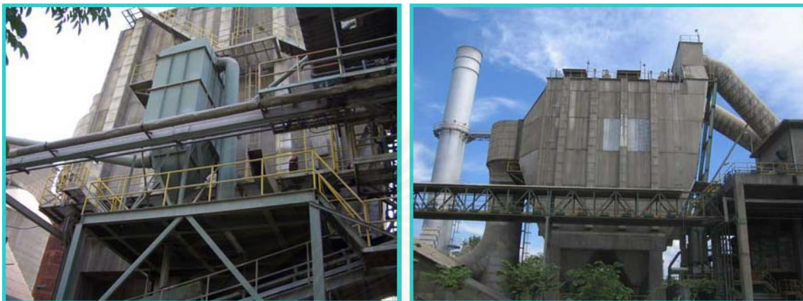
รูปที่ ง.1 : ระบบดักฝุ่นชนิดถุงกรอง (BF) และระบบไฟฟ้าสถิต (ESP)
