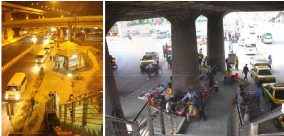
ภาพที่ 5.5 แสดงพื้นที่จุดเปลี่ยนถ่ายการสัญจรบริเวณใต้ทางยกระดับข้ามแยกรังสิต
