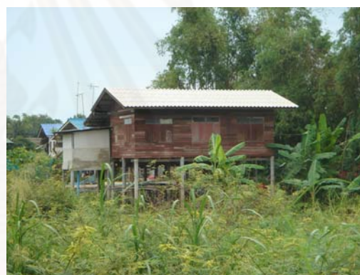
ภาพที่ 3.20 วัสดุที่ใช้ในการก่อสร้างสถาปัตยกรรม: การใช้ไม้จริงเป็นวัสดุหลักที่ใช้ในการก่อสร้างตัวอาคารพักอาศัย
