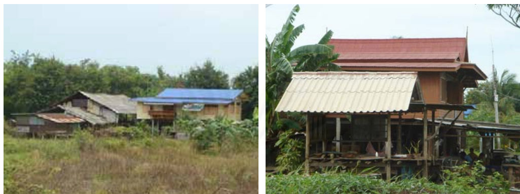
ภาพที่ 3.24 วัสดุที่ใช้ในการก่อสร้างสถาปัตยกรรม: วัสดุที่ใช้มุงหลังคาในพื้นที่โครงการฯ ได้แก่ สังกะสี และกระเบื้องลอน
