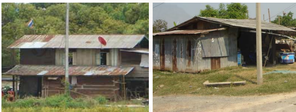
ภาพที่ 3.23 วัสดุที่ใช้ในการก่อสร้างสถาปัตยกรรม: ส่วนเก็บของใช้สังกะสีเป็นวัสดุในการกั้นฝาผนัง
