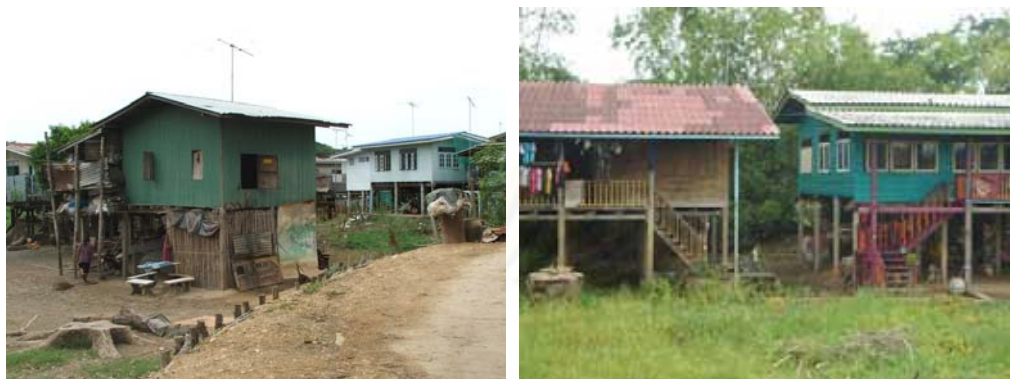
ภาพที่ 3.17 รูปทรงของสถาปัตยกรรม: (ภาพซ้าย) บ้านยกใต้ถุนสูงมีการกันฝาบริเวณใต้ถุนเป็นบางส่วน (ภาพขวา) ใต้ถุนแบบเปิดโล่งทั้งหมดไม่มีการกันฝา เป็นรูปแบบที่มีมาตั้งแต่ในอดีต หมู่ที่ 5 ต.สะพานไทย อ.บางบาล
