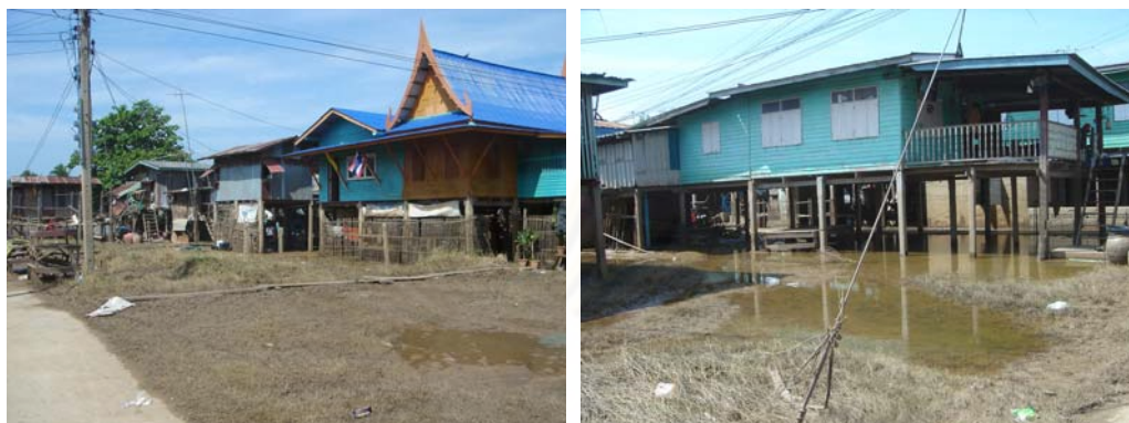
ภาพที่ 3.31 ภูมิทัศน์รอบบริเวณบ้าน: บริเวณรอบตัวบ้านถูกปล่อยให้โล่ง เนื่องจากเป็นพื้นที่ที่น้ำท่วมถึง
