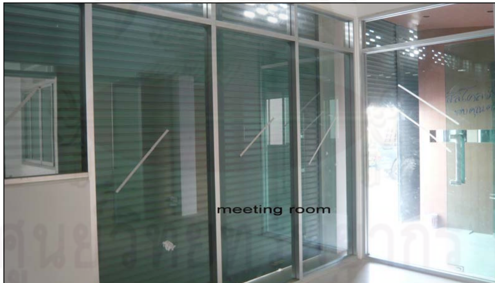
รูปที่ 3.13 งานกระจกและอลูมิเนียม
