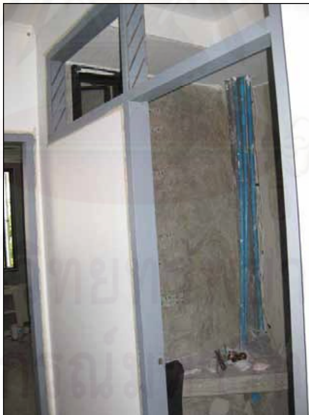
รูปที่ 3.9 การเตรียมความพร้อมด้านระบบประปา
