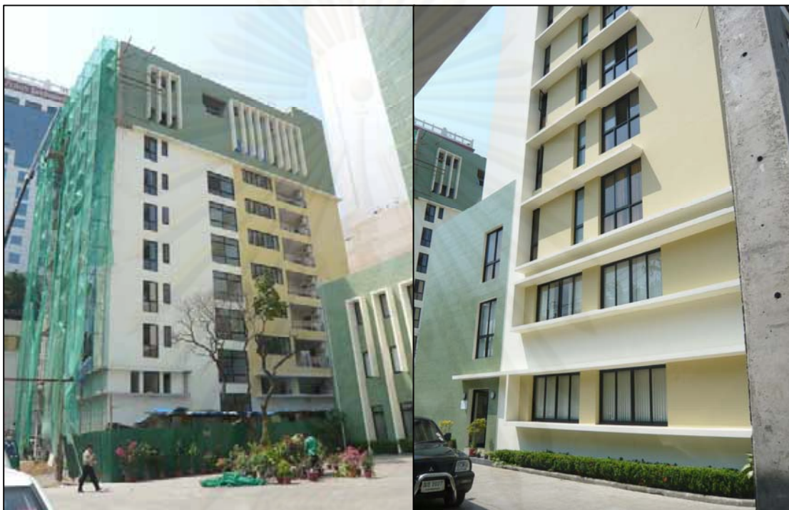
รูปที่ 3.1 ลักษณะภายนอกอาคาร
