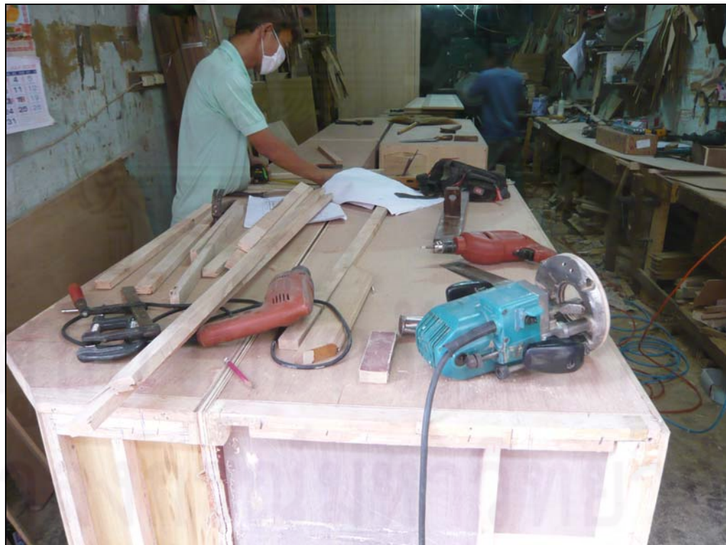
รูปที่ 3.11 งานไม้
