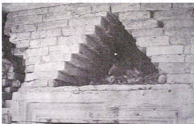
รูปที่ 5.11 การก่อผนังอิฐบนคานทับหลัง [20]
