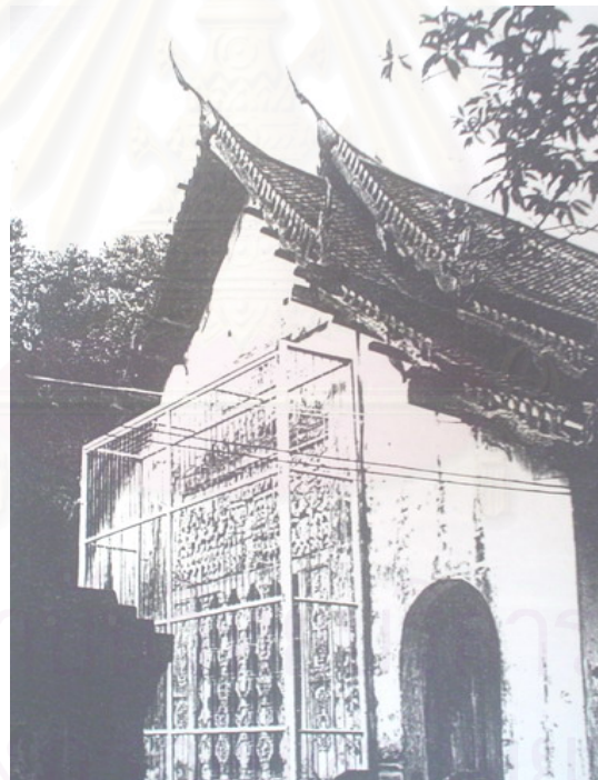
รูปที่ 6.18 การก่อผนังด้านหุ้มกลองไปรับน้ำหนักอกไก่ [57]
