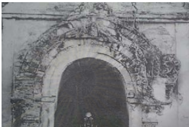
รูปที่ 5.26 การก่อโค้งเป็นซุ้มจระนมของเจดีย์หลวง วัดเจดีย์หลวง จังหวัดเชียงใหม่ [9]
