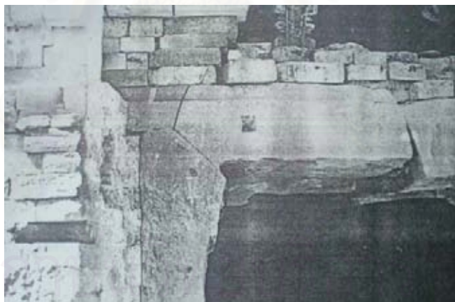
รูปที่ 5.6 การเข้ากรอบประตูแบบรอยต่อ 3 แนวที่ปราสาทยายเหงา [26]
