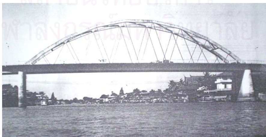
รูปที่ 5.41 สะพานปรีดีอำรง สะพานคอนกรีตอัดแรงแห่งแรกของประเทศไทย [103]
