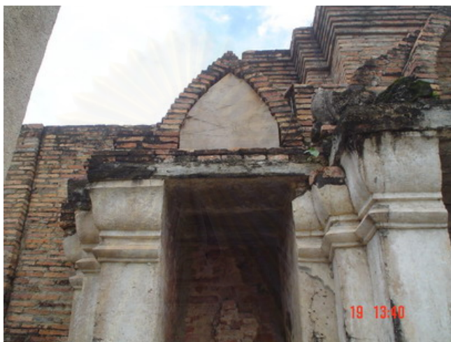
รูปที่ 5.19 การก่อซุ้มประดับ ไม่ได้รับน้ำหนักของโครงสร้างอื่น
