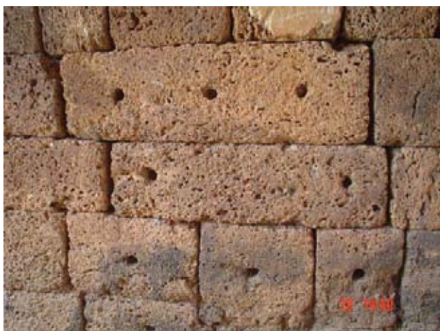
รูปที่ 5.4 ภูเขาอะบนศิลาแดง เพื่อใช้ในการเคลื่อนย้ายหิน
