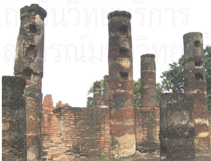
รูปที่ 5.12 ฐานเสาหินสำหรับเสียบคานไม้
