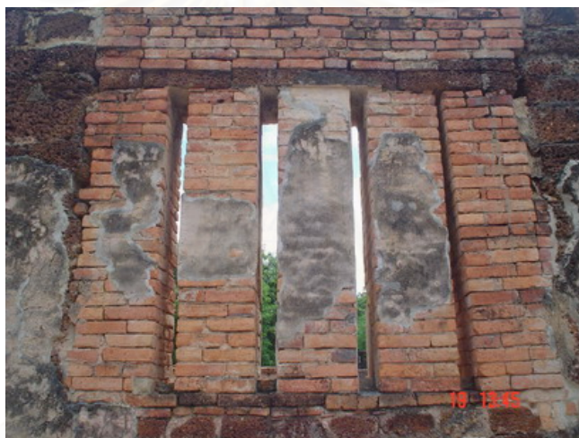
รูปที่ 5.14 ช่องเปิดแบบลูกมะหวดในอาคารสมัยสุโขทัย
