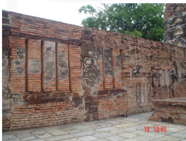
รูปที่ 5.15 การเจาะช่องเปิดตลอดผนังอาคารวิหารวัดศรีสวาย จังหวัดสุโขทัย
