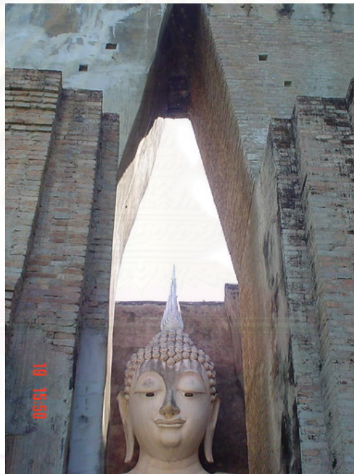
รูปที่ 5.16 ช่องเปิดแบบสันเหลี่ยมที่ประตูทางเข้ามณฑปวัดศรีชุม
