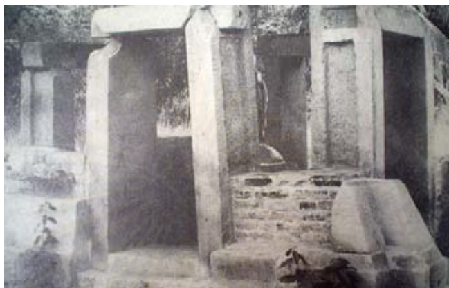
รูปที่ 5.1 ประตูปราสาทบ้านใหม่ไทยเจริญใช้หินทรายในการก่อสร้าง [25]
