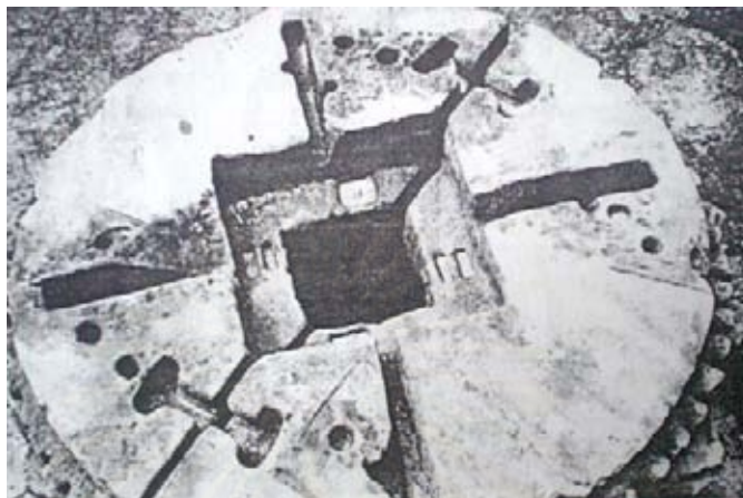
รูปที่ 5.2 ร่องรอยการสกัดหินเป็นร่องรูปตัว T และการใช้เหล็กรูปตัว I ในการก่อศิลาแดง [26]
