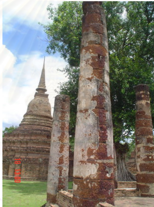
รูปที่ 5.21 เสาเชียงและร่องรอยการสอปูนและฉาบปูน (ภาพปัจจุบัน)
