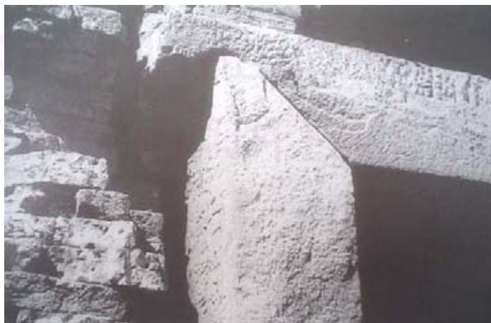
รูปที่ 5.9 การเข้ากรอบประตูแบบรอยต่อ 45 องศาที่ปราสาทเมืองต่ำ [25]
