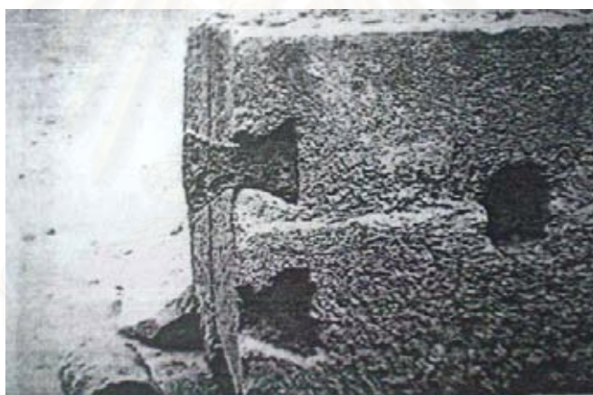
รูปที่ 5.3 การใช้เหล็กรูปปลิงเชื่อมศิลาแดง [35]
