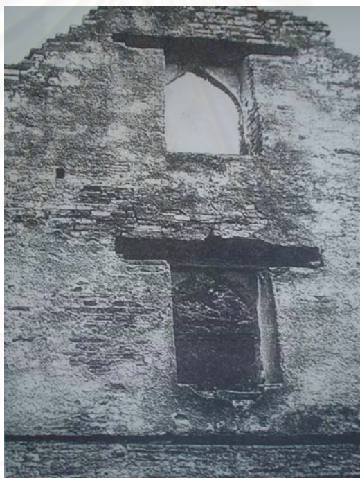
รูปที่ 5.36 ร่องรอยคานไม้เหนือช่องเปิด [57]
