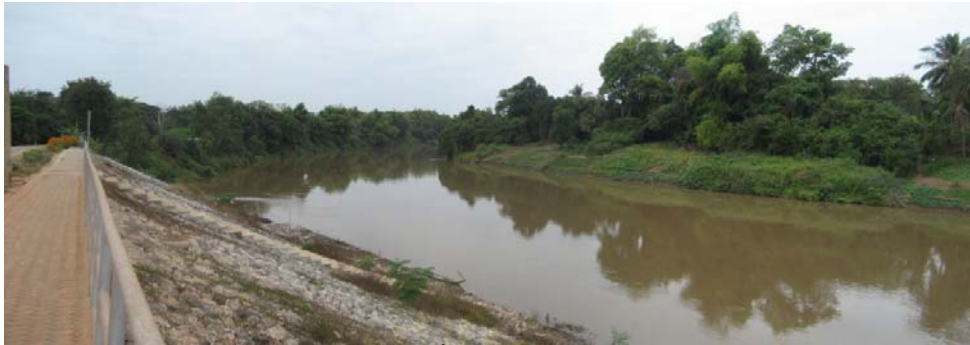
ภาพที่ 3-23 แสดงภาพบริเวณโค้งน้ำเขื่อนป้องกันตลิ่งพัง (สำรวจ 27 ธ.ค.2551)
