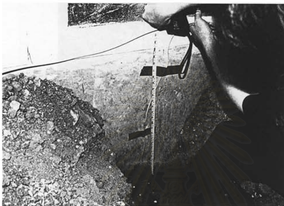
รูปที่ 3.10 แสดงการติดตั้งสายสัญญาณที่ความลึก 0.60 ม. ได้ผิวคิน
