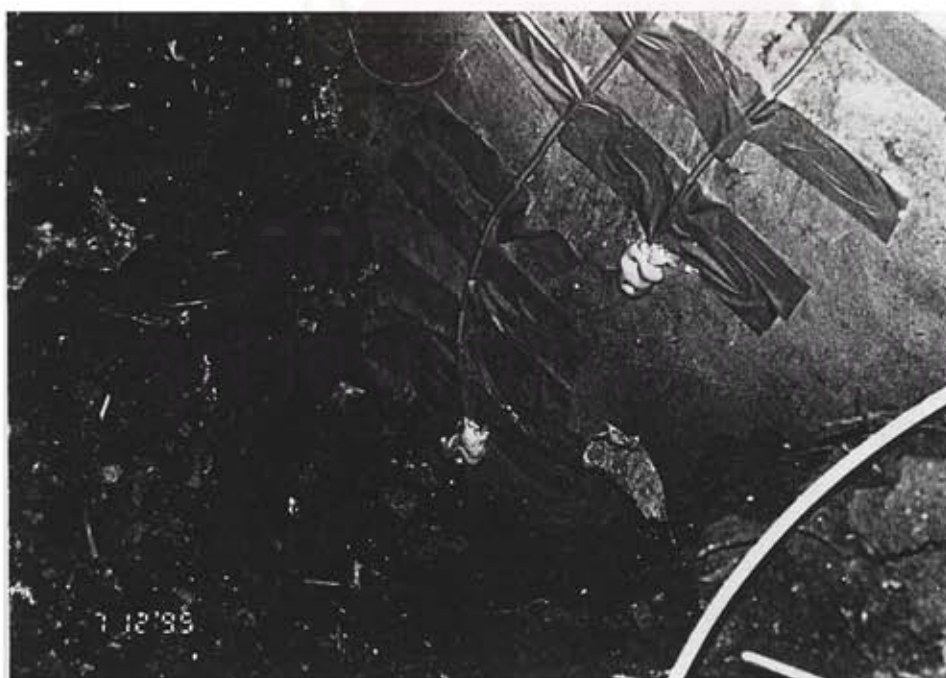
รูปที่ 3.11 แสดงการติดตั้งสายสัญญาณที่ความลึก 0.60 ม. และ 1.00 ม. ของผนังทางทิศใต้
