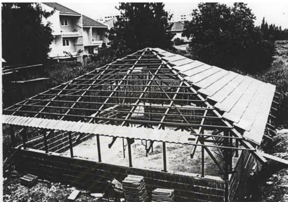
รูปที่ 3.8 รูปถ่ายจากด้านบนของอาคารที่ไร้ทคตบ
