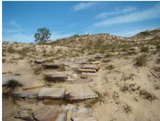
รูปที่ 2.15 แสดงทางเดินธรรมชาติแบบยกสูงที่อาจมีการเคลื่อนตัวและถูกทับถมจากทรายได้ จากการเคลื่อนตัวและปลิวของทราย
