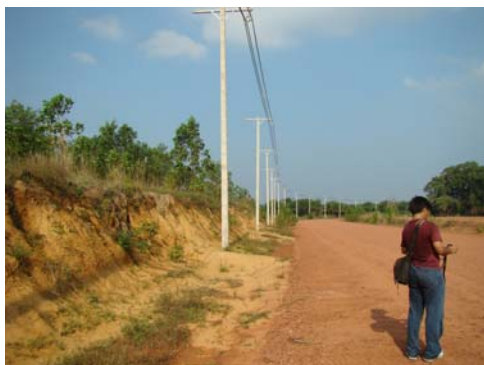
รูปที่ 3.52 แสดงการตัดถนนของกรมทางหลวงชนบท ที่ทำการตัดและขุด (Cut & Fill) บริเวณพื้นที่เนินทรายออกเพื่อทำการก่อสร้างถนน
