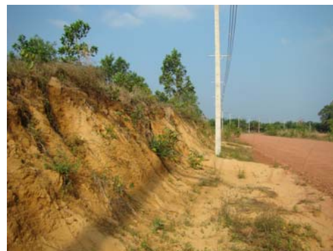
รูปที่ 3.52 แสดงการตัดถนนของกรมทางหลวงชนบท ที่ทำการตัดและขุด (Cut & Fill) บริเวณพื้นที่เนินทรายออกเพื่อทำการก่อสร้างถนน
