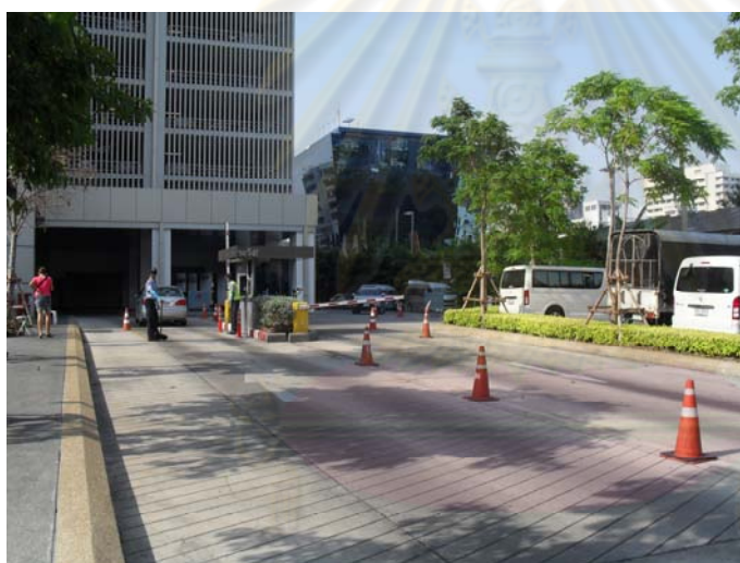
ภาพที่ 3-8 ถนนทางเข้าอาคาร C
