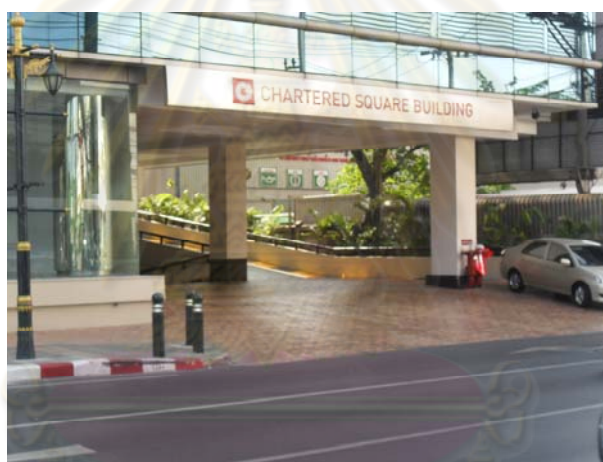
ภาพที่ 3-14 บริเวณทางเข้า-ออก อาคาร E
