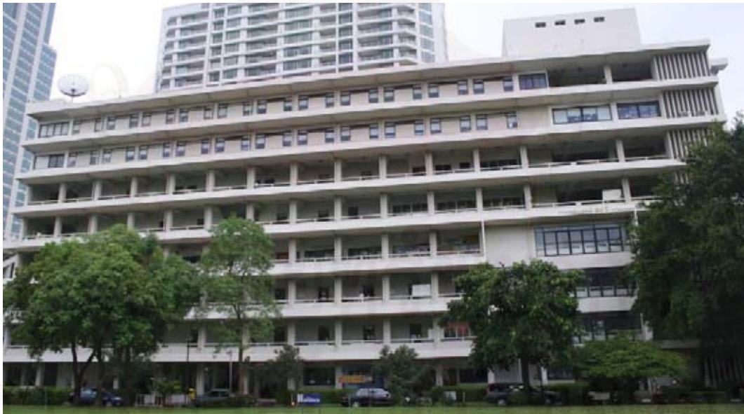
รูปที่ 4.1 ภาพถ่ายด้านหน้าอาคารตัวอย่าง
