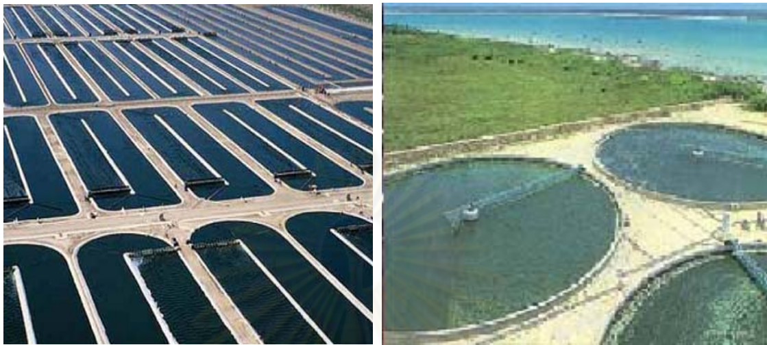
รูปที่ 2.3 ตัวอย่างของบ่อเพาะเลี้ยงสาหร่ายในระบบเปิด (1) Raceway pond (2) Circular ponds (Benemann, 2009)
