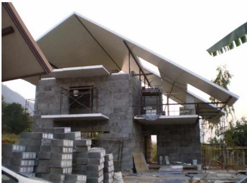
ภาพที่ 2-14 ขั้นตอนการก่อสร้างกรอบอาคารบ้านผู้สูงอายุด้วยวัสดุโฟมคอนกรีต (ณรงค์ฤทธิ์ จินต์จันทรวงศ์, 2551)
