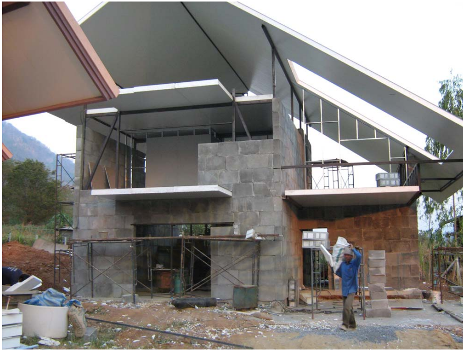
ภาพที่ 2-10 ขั้นตอนการก่อสร้างกรอบอาคารบ้านสุโลกร้อนด้วยวัสดุโฟมคอนกรีต (ณรงค์ ฤทธิ์ จินต์จันทรวงศ์, 2551)
