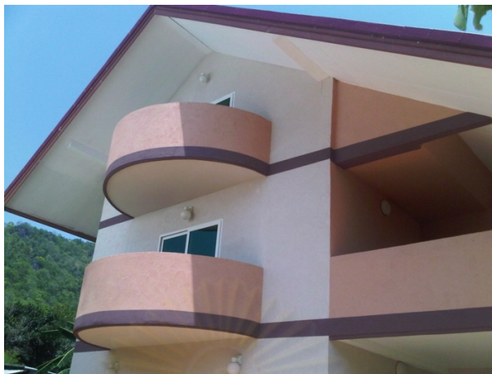
ภาพที่ 2-23 ซายคาที่ยาวเพื่อบังแสงแดดให้กับประตูและหน้าต่างของบ้านสู่โลกร้อน
