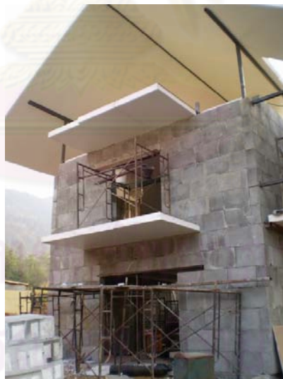
ภาพที่ 2-13 ขั้นตอนการก่อสร้างรอบอาคารชั้น 2 บ้านสู่โลกร้อนด้วยวัสดุโฟมคอนกรีต (ณรงค์ฤทธิ์ จินต์จันทรวงศ์, 2551)
