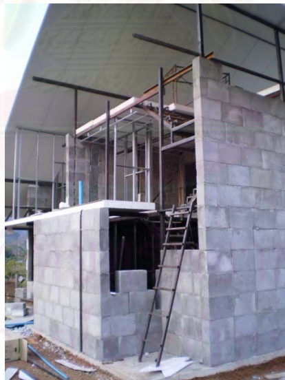
ภาพที่ 2-11 ขั้นตอนการก่อสร้างกรอบอาคารบ้านสุโลกร้อนด้วยวัสดุโฟมคอนกรีต (ณรงค์ ฤทธิ์ จินต์จันทรวงศ์, 2551)
