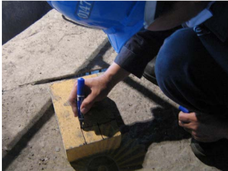
รูปที่ 4.9 การกำหนดตำแหน่งเพื่อเจาะฝังเทอร์โมคัปเปิล
