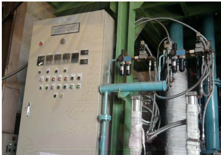
รูปที่ 4.16 ชุดควบคุมการทำงานของหัวเผาแบบรีเจนเนอเรทีฟ
