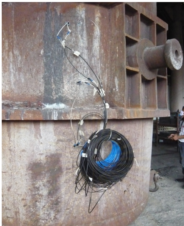
รูปที่ 4.11 การติดตั้งเทอร์โมคัปเปิลพร้อมกับการเก็บสายที่เรียบร้อยแล้ว
