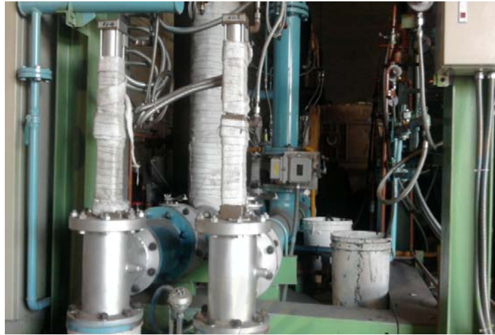
รูปที่ 4.15 ชุดท่ออากาศของระบบหัวเผาแบบรีเจนเนอเรทีฟ
