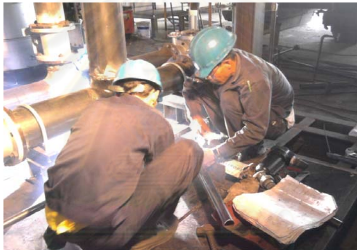
รูปที่ 4.13 การติดตั้งและการวางระบบท่อ
