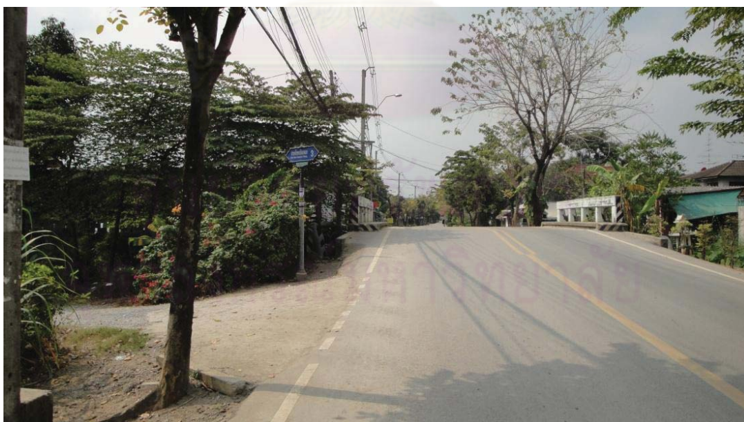
ภาพที่ 4-33 สภาพถนนสายปากน้ำ-กระโหลกทอง
