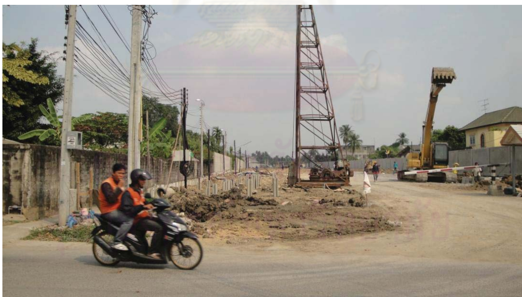
ภาพที่ 4-35 แนวก่อสร้างถนน พรานนก-พุทธมณฑล สาย4
