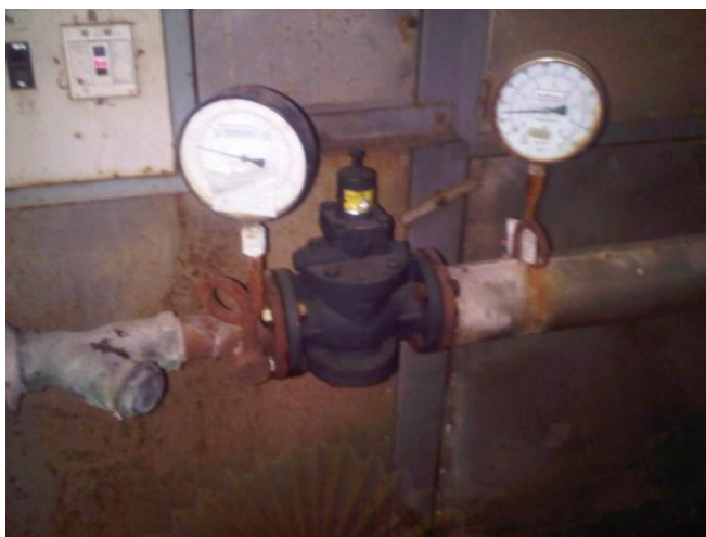
ภาพที่ 5.5 ภาพวาล์วและตัววัดความร้อนความดัน
