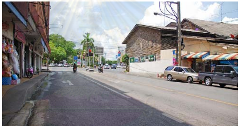
รูป 6.42 ถนนพิเศษกุล บริเวณจุดเชื่อมต่อนถนนพหลุง และถนนราชดำเนิน
