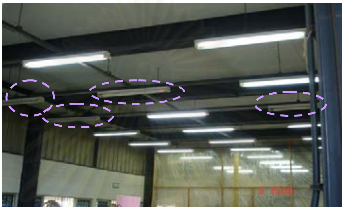
รูปที่ 4.10 การปิดหลอดไฟบางหลอดลงเพื่อประหยัดพลังงาน
