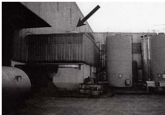
รูปที่ 3.25 หอระบายความร้อน (Cooling Tower)
