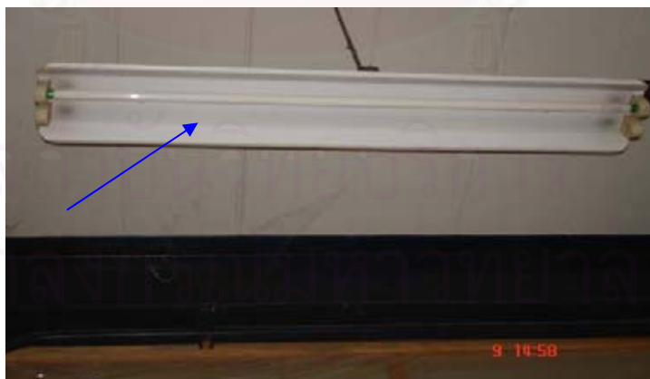
รูปที่ 4.11 ถอดหลอดไฟออกจากชุดโคมไฟรวม
