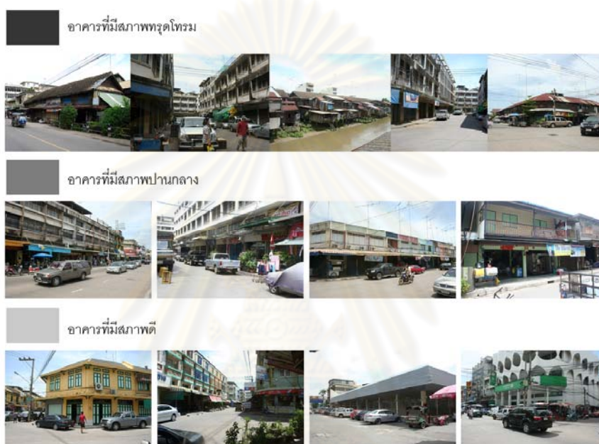
ภาพที่ 3.5 สภาพอาคารภายในพื้นที่โครงการ (ที่มา : โดยผู้วิจัย, 2552)
