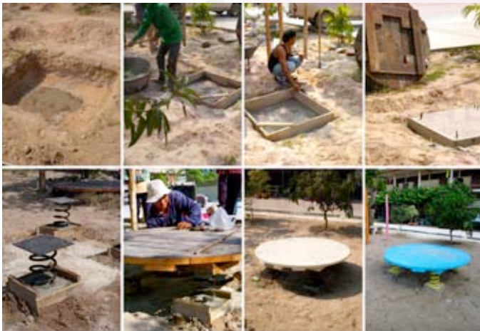
ภาพที่ 34 เครื่องเล่นที่อนุญาตให้ผู้เล่นขึ้นไปกระโดดได้นั้นจำเป็นมากที่ต้องคำนึงถึงฐานรากที่แข็งแรงเพื่อป้องกันการพลิกคว่ำที่อาจเกิดขึ้นจากการเล่น ภายหลังการติดตั้งที่เสร็จสมบูรณ์จึงทาสีเพื่อรักษาเนื้อไม้และเลือกสีที่สดใสเพื่อดึงดูดใจให้เด็กเข้ามาเล่น
