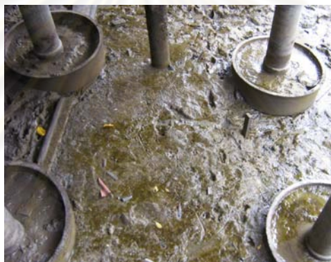
ภาพที่ 5-18 (C) ตะกอนดินสะสมจนขวางการไหลของน้ำ
