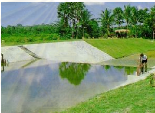
ภาพที่ 2-9 ตัวอย่างการสร้างผนังกันน้ำ เหมาะกับการควบคุมกระแสน้ำ และปริมาณน้ำไม่ให้เกิดน้ำท่วมชุมชน และมีพื้นที่กักเก็บน้ำไว้เพื่อทำเกษตรกรรมหรือกิจกรรมหลักของชุมชนเหมาะสำหรับพื้นที่หลายระดับทั้งระดับเมือง หรือชุมชนเล็กๆ (ที่มา: http://www.aurum.co.th/images/column_1236928235/1_display17_1.jpg )
