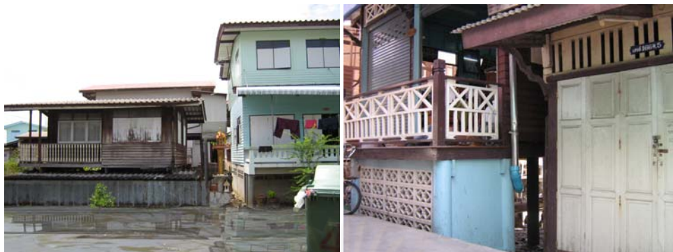
ภาพที่ 5-21 สภาพอาคารที่ถูกละทิ้งพื้นที่อาคารชั้นล่าง และอยู่อาศัยแต่อาคารชั้นบนแทน (ที่มา: ผู้วิจัย, 2553)
