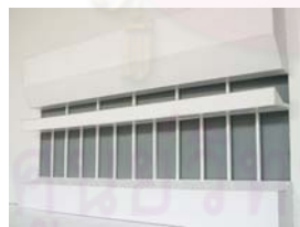
ภาพที่ 3.2 แสดง light shelves ภายนอกรูปทรงปรับมุม 30 องศาพร้อมแนวคิดการนำแสงเข้ามาในอาคาร
