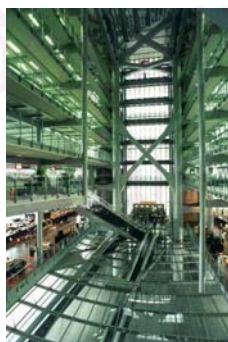
ภาพที่ 2.47 แสดงการใช้ specular reflectors (another way of thinking about light shelves) บน atrium อาคาร Hong Kong Shanghai bank (Alison G.Kwok and Walter T. Grondzik : 84)
