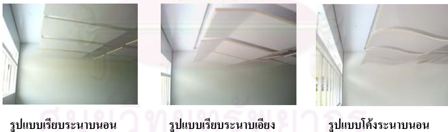
แผนภูมิที่ 4.15 เปรียบเทียบประสิทธิภาพในการนำแสงเข้ามาในอาคารด้วย daylighting panels วัสดุ spread reflect. รูปแบบต่างๆที่ระดับ 2.50 m.
