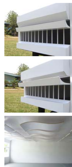
ภาพที่ 6.5 แสดงรูปแบบช่องเปิดทึศเหนือ-ใ้ที่มีการใ้ interior daylighting panels ใ้กระนาบนอน ร่วมกับ light shelves ที่ช่องเปิดแบบโค้ง
