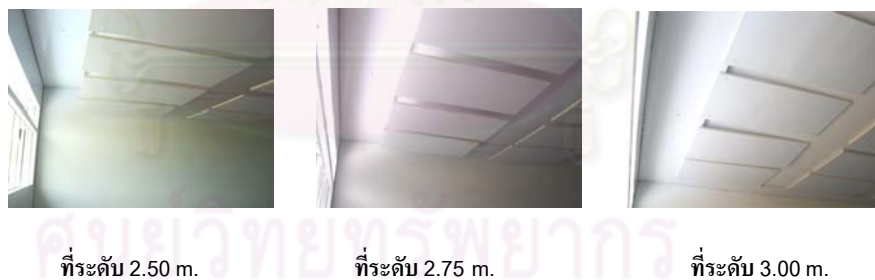
แผนภูมิที่ 4.63 เปรียบเทียบประสิทธิภาพในการนำแสงเข้ามาในอาคารด้วย daylighting panels รูปแบบเรียบระนาบนอน วัสดุ spread ที่ระดับต่างๆ
