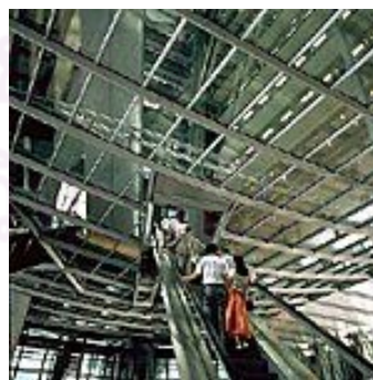
ภาพที่ 2.47 แสดงการใช้ specular reflectors (another way of thinking about light shelves) บน atrium อาคาร Hong Kong Shanghai bank (Alison G.Kwok and Walter T. Grondzik : 84)
