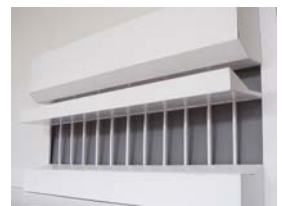
ภาพที่ 3.2 แสดง light shelves ภายนอกรูปทรงปรับมุม 30 องศาพร้อมแนวคิดการนำแสงเข้ามาในอาคาร
