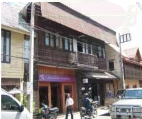
ลำดับที่ 6 บ้านเลขที่: 124 ถ.เจริญราษฎร์ ชื่ออาคารในปัจจุบัน : บ้านพันธุศิลป์ อายุอาคาร: 89 ปี
