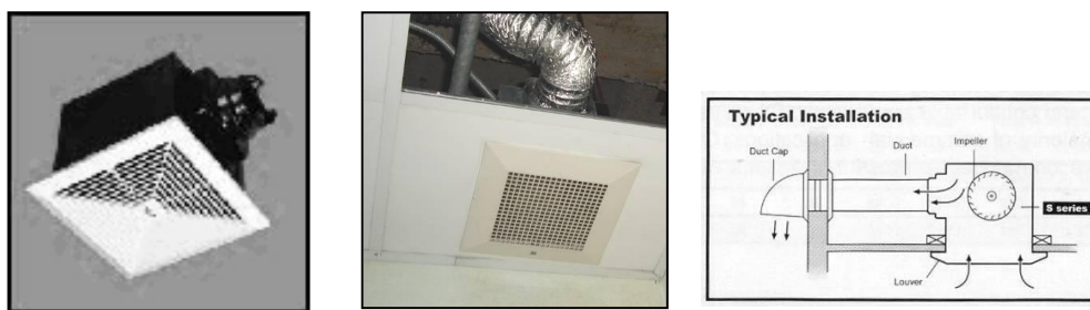
ภาพที่ 2.9 แสดงตัวอย่างพัดลมระบายอากาศชนิดติดเพดานและการทำงานของระบบ (ที่มา ปัญหาการระบายอากาศและแนวทางแก้ไข, ศูนย์วิศวกรรมกรรมการแพทย์ที่ 3 นครสวรรค์)
