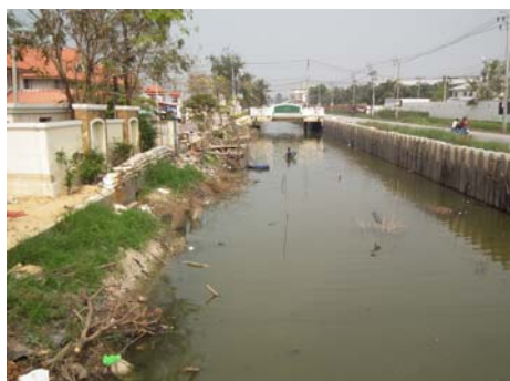
ภาพที่ 4-17 รูปภาพคลองถนนหน้าโครงการ
