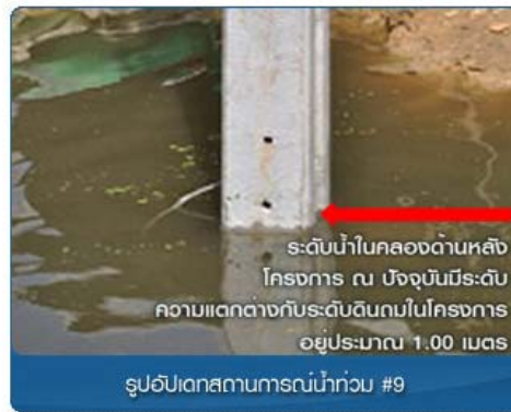
ภาพที่ 6-22 รูปถ่ายการวัดระดับน้ำ
