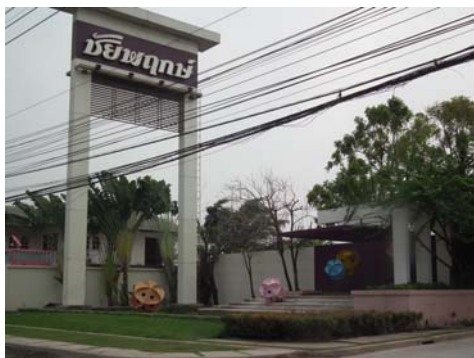
ภาพที่ 4-54 รูปถ่ายน้ำท่วม H = 1.00 ม.
