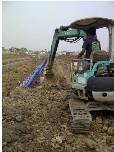
ภาพที่ 6-30 รูปถ่ายระบบกันซึมรั้วโครงการใต้ดิน
