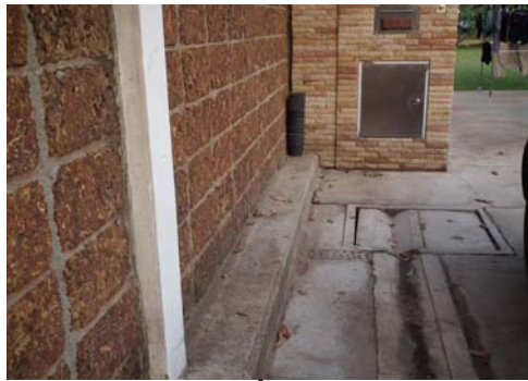
ภาพที่ 6-13 รูปถ่ายรั้วโครงการศิลาแลง
