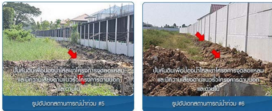
ภาพที่ 5-82 รูปถ่ายแนวถมดินปิดรั้วโครงการ
