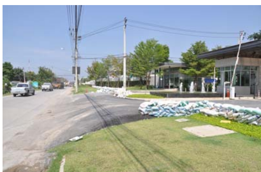
ภาพที่ 5-60 รูปถ่ายการทำเนินกั้นน้ำแอสฟัลท์
