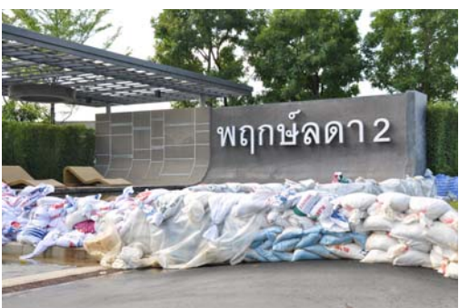
ภาพที่ 5-61 รูปถ่ายการกั้นกระสอบทรายสูงขึ้น
