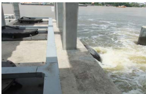
ภาพที่ 5-16 รูปถ่ายการสูบน้ำระบายลงคลอง
