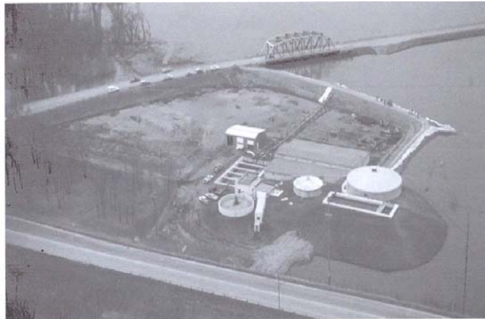
ภาพที่ 2-7 การทำคั่นกันน้ำป้องกันน้ำท่วม
