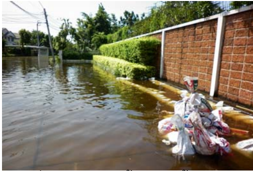
ภาพที่ 5-24 รูปถ่ายน้ำท่วมผนังรั้วโครงการ
