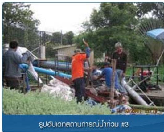
ภาพที่ 5-33 รูปถ่ายการติดตั้งเครื่องสูบน้ำ
