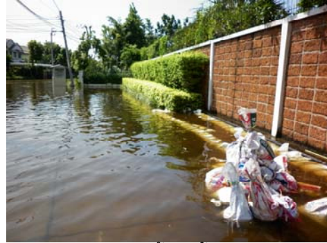
ภาพที่ 6-14 รูปถ่ายน้ำซึมรั้วโครงการศิลาแลง
