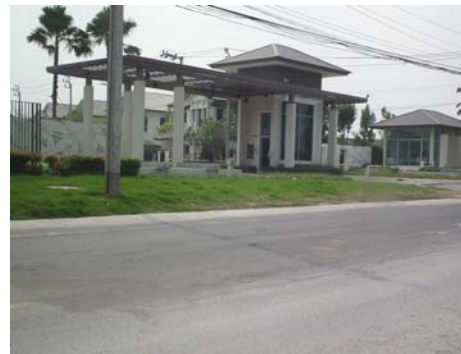
ภาพที่ 4-53 รูปถ่ายน้ำท่วม H = 1.20 ม.
