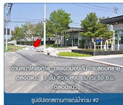
ภาพที่ 6-24 รูปถ่ายการกันกระสอบทราย ภาพที่ 6-25 รูปถ่ายคั่นกันน้ำยางแอสฟัลท์
