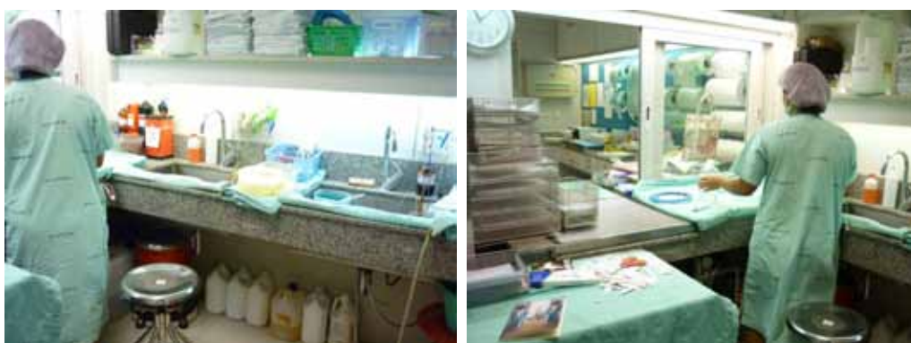
ภาพที่ 4-78 แสดงส่วน Slop Sink ใหญ่หรือห้อง Wash ทำหน้าที่ล้างอุปกรณ์เครื่องมือสกปรกที่มาจากทุกห้องผ่าตัด ก่อนส่งต่อยังห้อง Pack ซึ่งถือเป็นพื้นที่ Intermediate Zone ดังนั้นแล้วเจ้าหน้าที่บริเวณห้อง Wash จึงถูกแยกออกจากเจ้าหน้าที่ห้อง Pack (ภาพที่ 4-62) โดยชัดเจน ไม่มีการทำงานข้ามพื้นที่กัน
