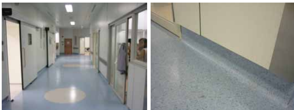
ภาพที่ 2-69 แสดงลักษณะพื้น และรอยต่อพื้นกับผนัง ของเส้นทางสัญจรในหน่วยงานผ่าตัด (ศูนย์การแพทย์สิริกิติ์ โรงพยาบาลรามารบิตี :21 กันยายน 2554 )
