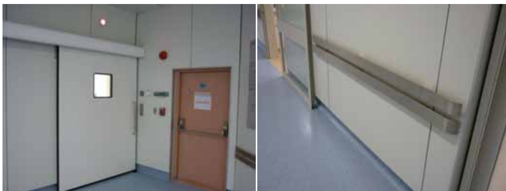
ภาพที่ 2-70 แสดงลักษณะผนังสำเร็จรูป และ Wall Guard ของเส้นทางสัญจรในหน่วยงานผ่าตัด (ศูนย์การแพทย์ศิริกิติ์ โรงพยาบาลรามารบิตี :21 กันยายน 2554 )
