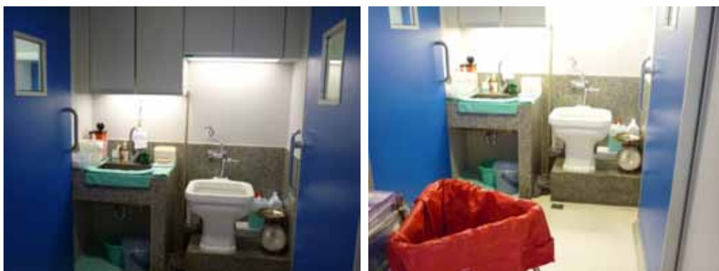
ภาพที่ 4-77 แสดงห้อง Slop Sink ที่คั่นระหว่างหลังห้องผ่าตัด และเส้นทางสัญจรภายนอก จากภาพจะเห็นประตู 2 บานซ้ายขวา คือประตูทางเชื่อมจากห้องผ่าตัด 2 ห้องมายัง Slop Sink เพื่อทำการคัดแยก ล้าง อุปกรณ์เครื่องมือสกปรกต่างๆ
