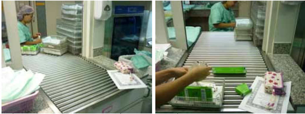
ภาพที่ 4-61 แสดงส่วนหน้าต่างทางเชื่อมจากห้องล้างมืออุปกรณ์สกปรก (Wash) มายังห้องบรรจุหีบห่ออุปกรณ์เครื่องมือ เพื่อนำเข้าอบในตู้อบ Auto Clave ให้เป็นอุปกรณ์เครื่องมือปราศจากเชื้อ ซึ่งจะทำในกรณีอุปกรณ์เครื่องมือปลอดเชื้อไม่เพียงพอเท่านั้น
