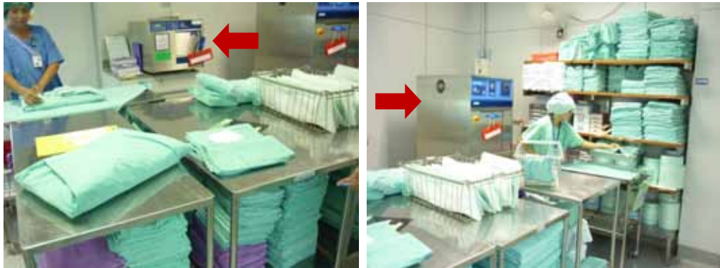
ภาพที่ 4-62 แสดงห้อง Pack ภายในหน่วยงานผ่าตัด ทำหน้าที่บรรจุหีบห่ออุปกรณ์เครื่องมือสะอาดก่อนจะนำไปอบฆ่าเชื้อให้เป็นอุปกรณ์เครื่องมือปราศจากเชื้อ จากรูปทั้งทางด้านซ้ายและขวาจะเห็นตู้ Auto Clave ขนาดต่างๆกันตั้งอยู่
