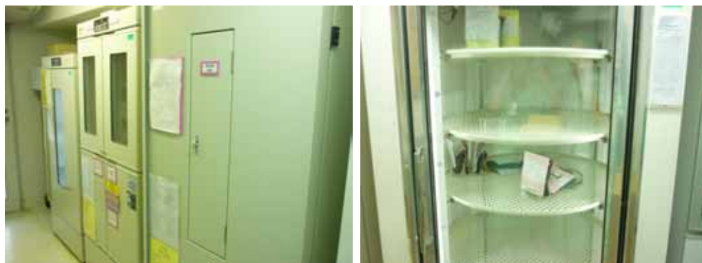
ภาพที่ 4-68 แสดงห้องเก็บเวชภัณฑ์สะอาดประเภทเลือด หรือยาที่ต้องอยู่ในอุณหภูมิต่ำจะถูกเก็บในตู้ควบคุมอุณหภูมิ รวมถึงมีเครื่องควบคุมอุณหภูมิสำหรับอุ่นน้ำเกลือก่อนนำไปใช้ผู้ป่วยอีกด้วย
