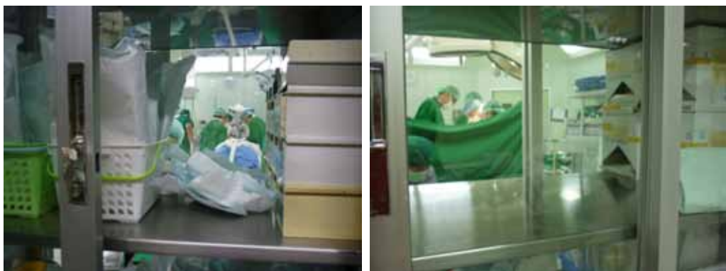
ภาพที่ 4-25 แสดงตู้หน้าต่างกระจกที่เชื่อมต่อระหว่างห้องผ่าตัดกับห้องเก็บอุปกรณ์เครื่องมือปลอดเชื้อ ไว้สำหรับเก็บอุปกรณ์ปลอดเชื้อพื้นฐานขนาดเล็กเพื่อให้สามารถหยิบใช้ได้โดยสะดวก นอกจากนี้ยังทำหน้าที่แทนประตูในการส่งเครื่องมือในกรณีที่กำลังผ่าตัดต่ออยู่อีกด้วย
