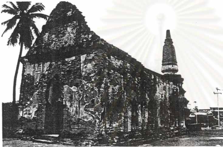
ภาพที่ 4.34 สภาพพระอุโบสถวัด บันไดหินในปัจจุบัน สามารถทำการ ศึกษาได้จากผนังด้านสกัดและผนัง โดยรอบอาคาร
